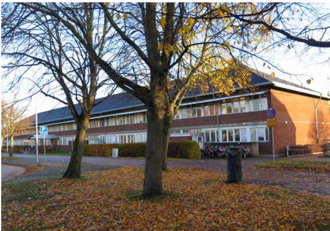
Den långsträckt klassrumsbyggnaden utmed Ängkärrsvägen är ett påtagligt inslag i gatubilden utmed huvudvägen genom området. De valmade sadeltaken är tydligt präglade för skolanläggningen.
