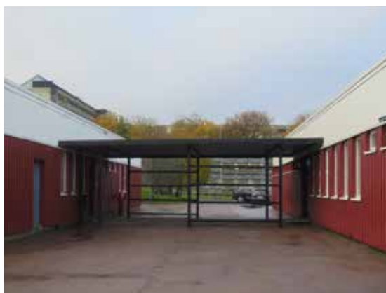
Den taktäckta gången mellan skolans två byggnader är en viktig värdebärande detalj.
