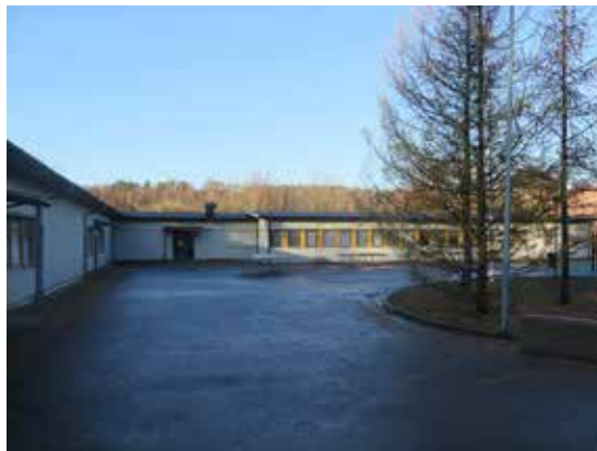
Den ursprungliga, vinkelbyggda klassrumsbyggnaden i en våning.
