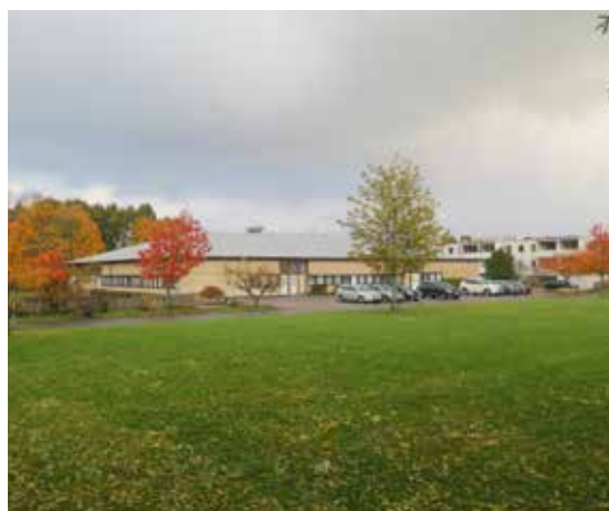
Den nästintill kvadratiske före detta skolanläggningen med sitt flacka sadeltak.
