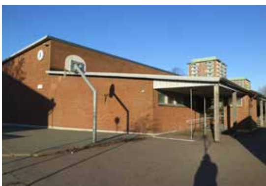
Gymnastikbyggnadens fasad mot gården.
