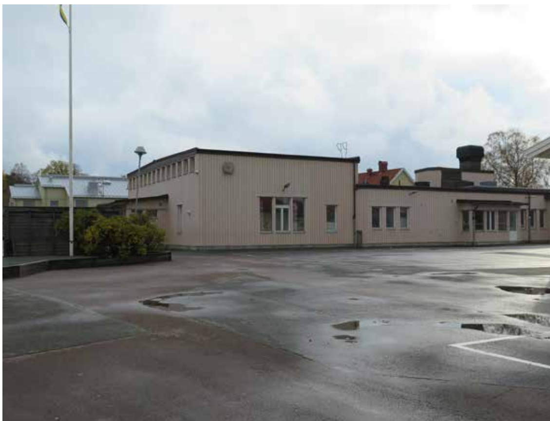
Byggnaden för gymnastik och matsal med fasader klädda i rosa lockpanel. Gymnastiksalens högdel är ett markant inslag i skolanläggningen med sina fönsterpartier åt öster och norr.
