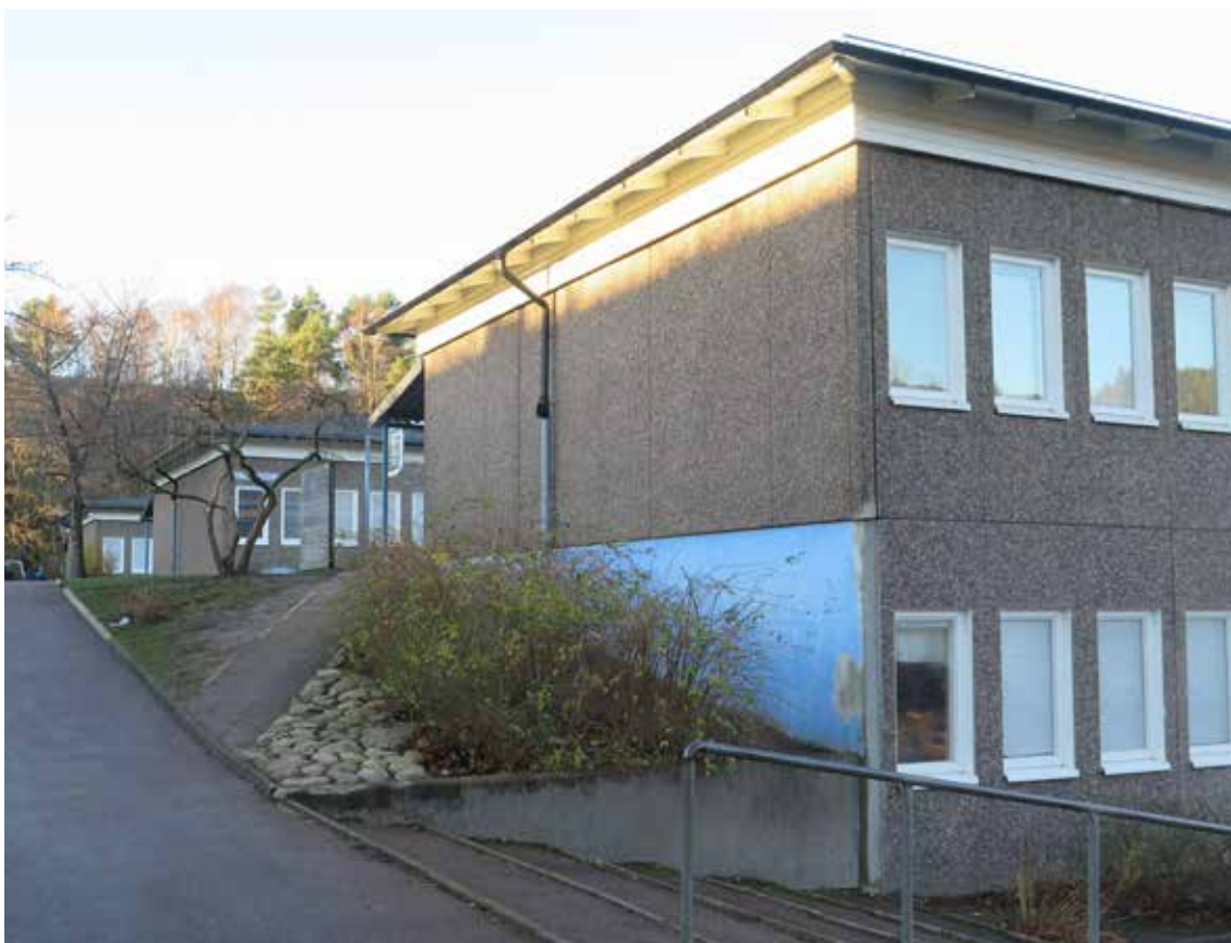
Mot söder blir skolbyggnadens kamformade grundstruktur tydlig. Mellan de fyra armarna skapas mindre gårdsrums. Mot denna sida är byggnaden bara en våning.
