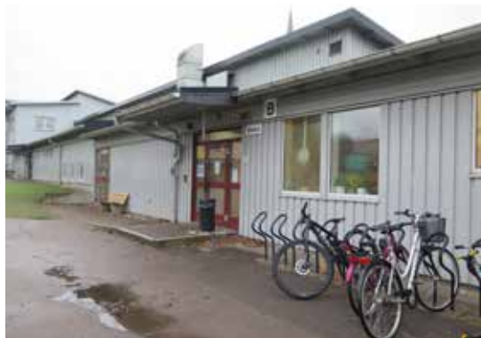
1980-talsskolbyggnadens fasad mot gården i nordväst. Byggnaden uppfördes som ett tillägg till en äldre skolmiljö.
