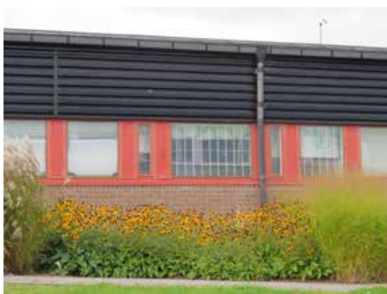
Rödbrunt tegel är tillsammans med svart och röd plåt ett tydligt signum för skolanläggningen.
