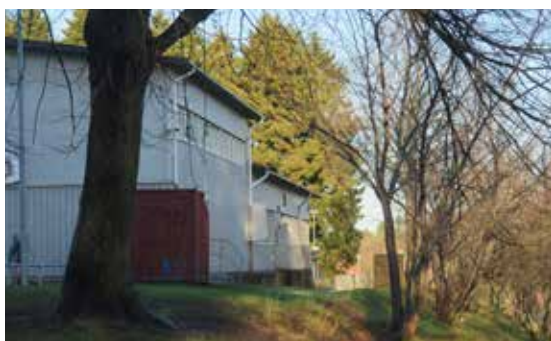
Den östra ursprungliga längan har en markerad högdal för gymnastiksalen.
