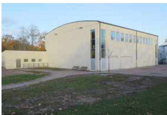
Gymnastikbyggnadens högdel mot skolgården.
