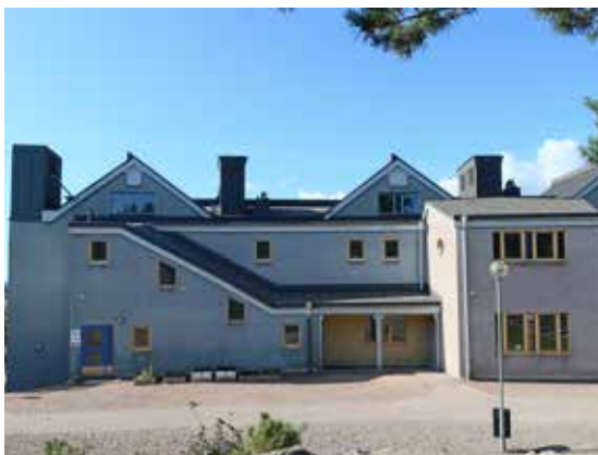
De utanpåliggande trapphusens form och fönstersättning är tillsammans med dörrar karaktärsskapande inslag.
