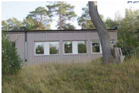
Fönstersättningen speglar byggnadernas klassrumsindelning. Ovan fönstren är panelen liggande.
