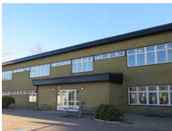
Den ursprungliga byggnadens fasad mot väster med varierad fönstersättning och utanpåliggande entrépartier.
