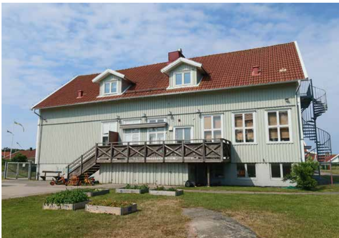
Den lilla folkskolebyggnaden från år 1952. De höga korspostfönstren markerar tydligt klassrummens utbredning på fasaden. Altanen och brandtrappan är senare tillkomna.
