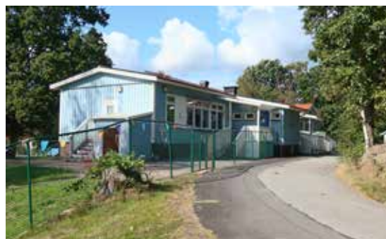
Den ursprungliga paviljongen med sina stora fönsterpartier.
