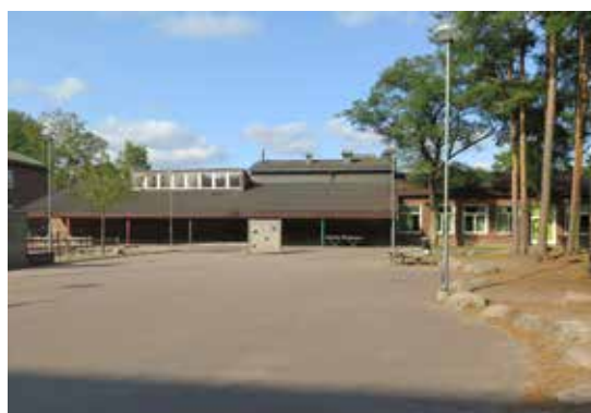
Matsalsbyggnadens gårdsfasad med skärmtak.
