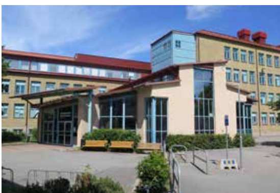
Det tillbyggda entrépartiet för "Lundby stadsdelshus".
