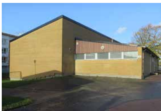
Gymnastikbyggnaden med en karaktäristisk högdal.
