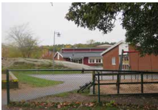
Trots förändringar är anläggningens fasadindelning bevarad.
