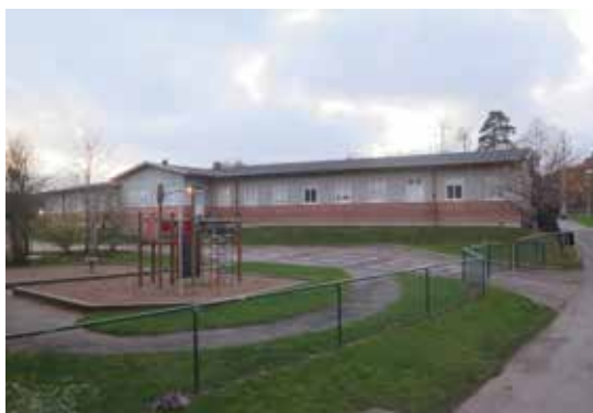
Den ditflyttade mellanstadiebyggnaden.
