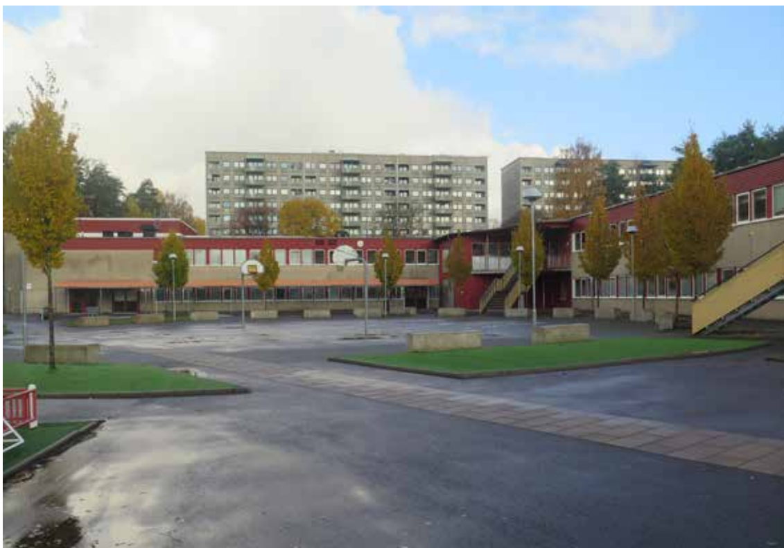
Nytorpsskolans två ursprungliga byggnader är uppförda i vinkel till varandra, på den östra och norra sidan av skolgården. Klassrumsbyggnaden till höger har senare byggts till med utvändiga trappor mot gården.
