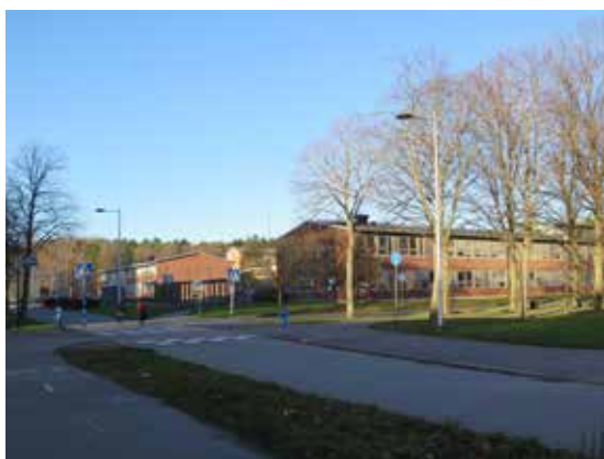
Från sydost annonseras skolan av de två ursprungliga klassrumsbyggnaderna i två våningar.
