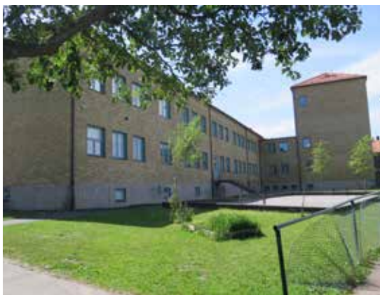
Den norra klassrumslängan sedd från gångvägen i norr. Byggnaden består av tre sammanfogade byggnadskroppar.
