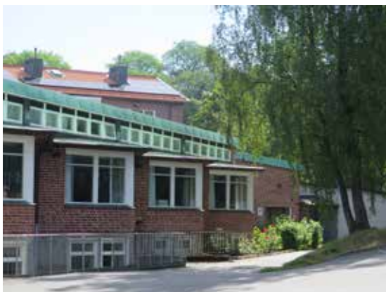
Lågstadiedelen i en våning med sina karaktärsskapande burspråk och överljuspartier.
