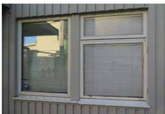
Vissa fönster har bytts ut, till höger ett bevarat träfönster.
