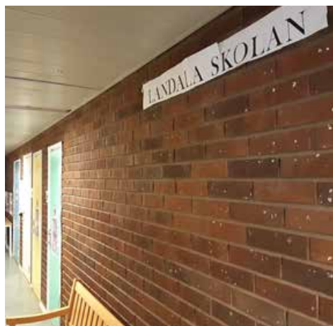
.... medan motstående vägg är i tegel.
