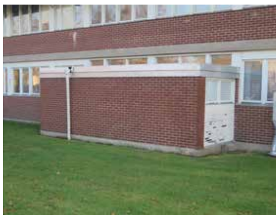
Mindre utskjutande delar mot gatan i väster.
