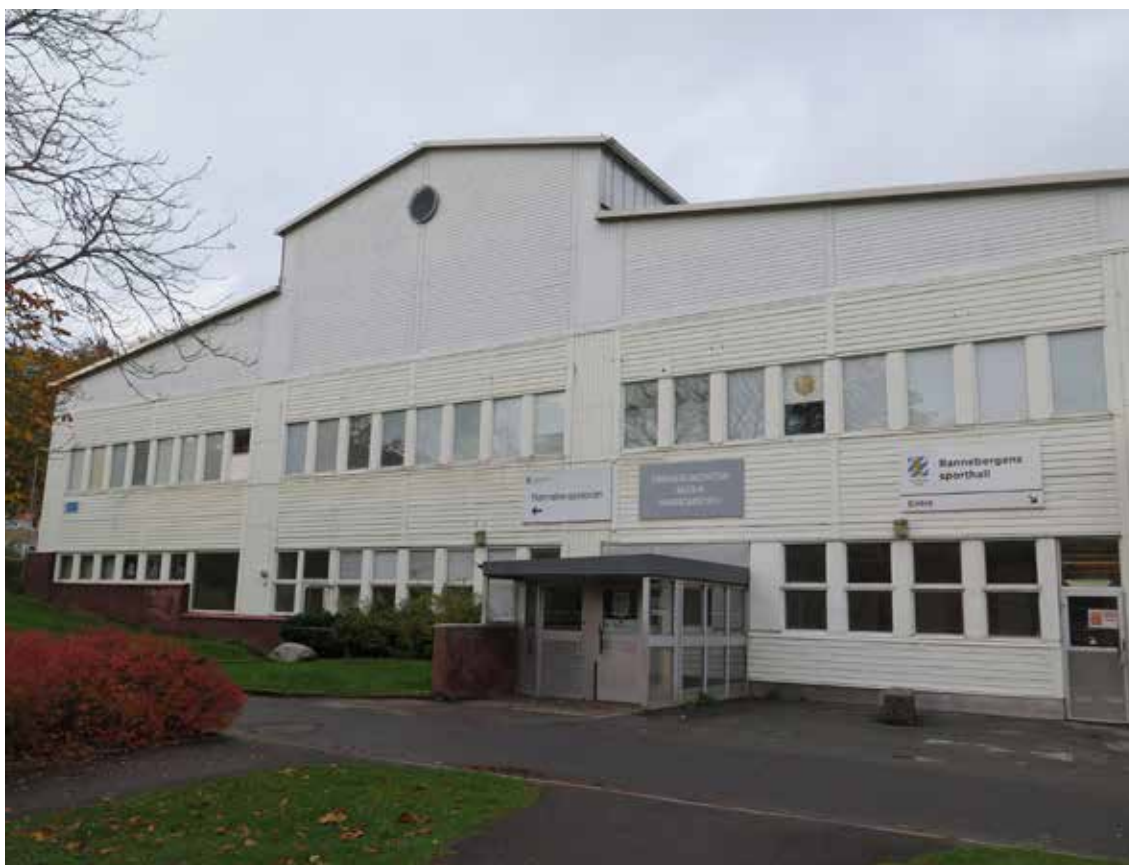
Centrumanläggningens södra gavel med sin sedan år 1997 helt förändrade takform. Entréerna till skolan finns runt hörnet till vänster i bild.
