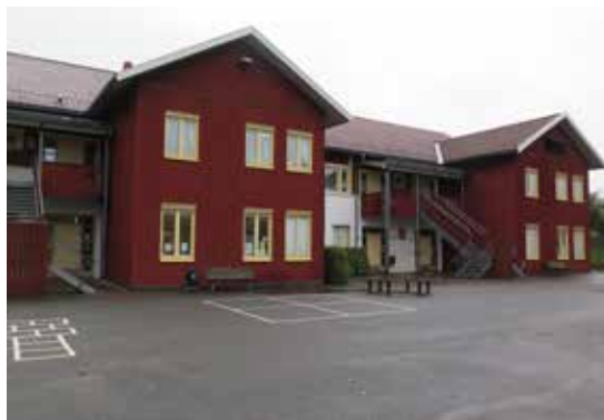
Delar av den ursprungliga skolbyggnadens gårdsfasad mot väster.
