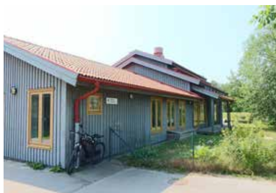
Förskolebyggnaden är delvis samgestaltad med skolan.
