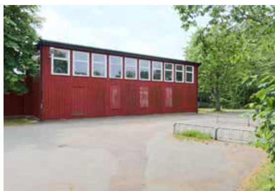
Den fristående gymnastikbyggnaden.
