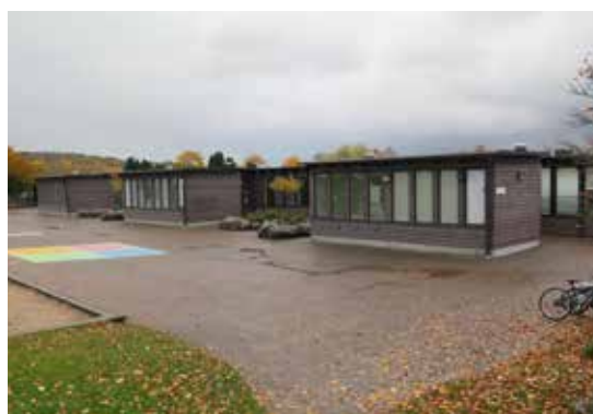
De utanpåliggande grupprummen.
