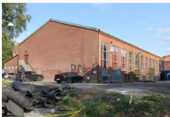
Ut mot spårvägen i väster ligger den fristående gymnastikbyggnaden med högsmla fönster åt söder.
