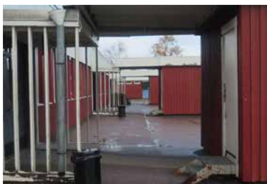
De utbyggda bodarna utanför de spaljeförsedda entréerna.
