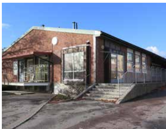
Matsalsbyggnadens gavelparti med sitt burspråk.
