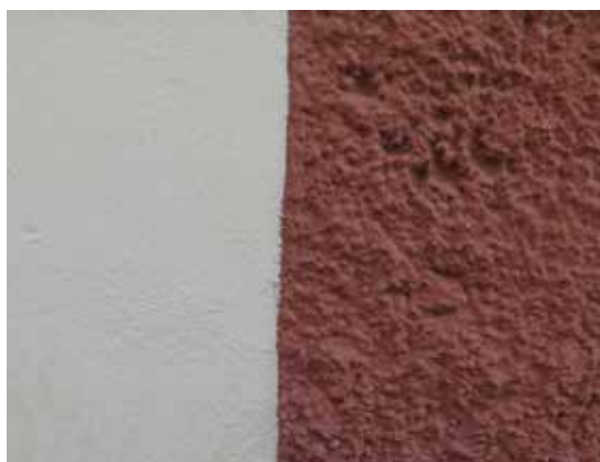
De putsade fasadernas indelning i vit slätputs och röd spritputs ger byggnaden karaktär.
