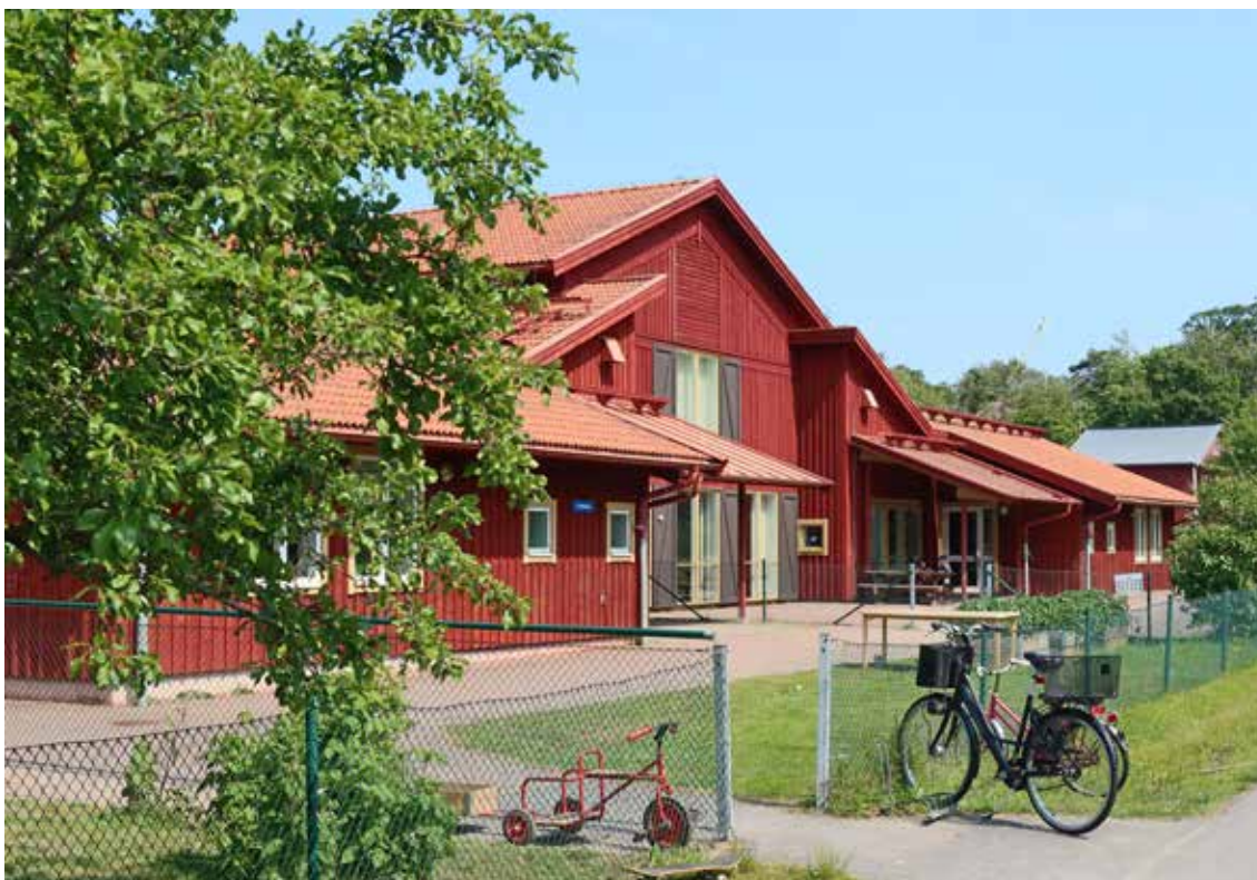
Skolans H-formade byggnadskropp utgår från den två våningar höga, centrala volymen. Åt norr vänder byggnaden sin höga gavel mot den öppna jordbruksmarken.
