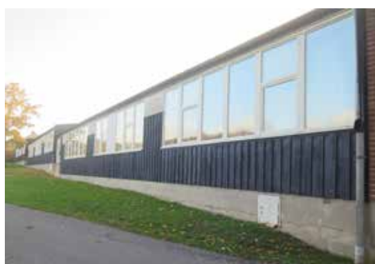
Lågstadiebyggnadens mer bibehållna fasader mot öster.
