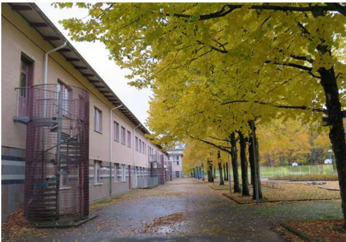
Lövgårdsskolan präglas idag till stora delar av den stora ombyggnad som skedde i början av 1990-talet, då fasaderna fick sin rosabeige färg och bottenvåning klädd i klinker.
