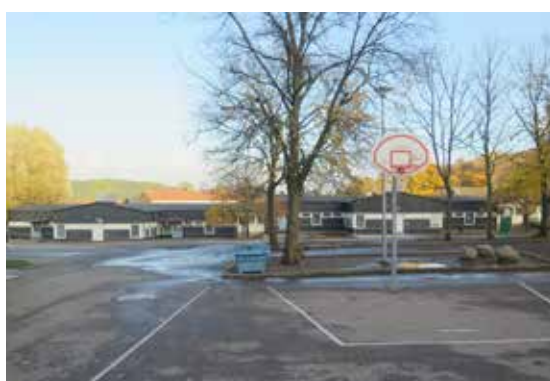
Lågstadiebyggnadens ombyggda fasader mot gården.
