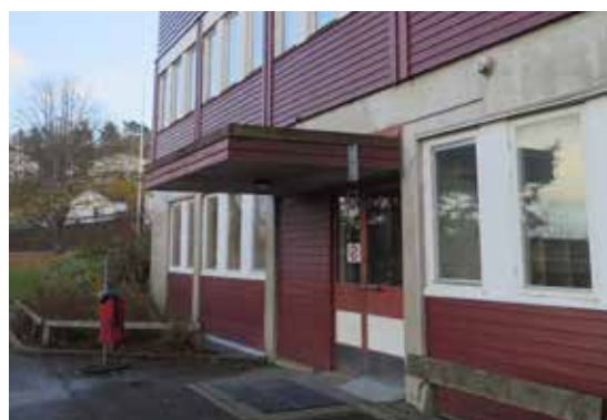
Bevarat entréparti med skärmtak mot norr.
