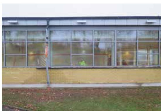
De gula tegelfasaderna bryts upp av långa fönsterband.
