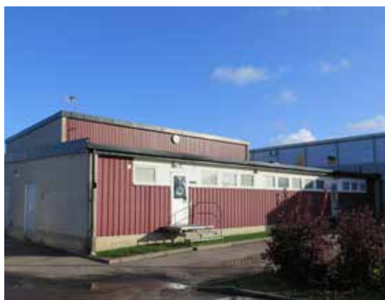
Gymnastikbyggnaden med den lägre omklädningsdelen närmast i bild.
