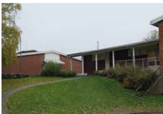
Den taktäckta gången över gymnastikbyggnadens entré.
