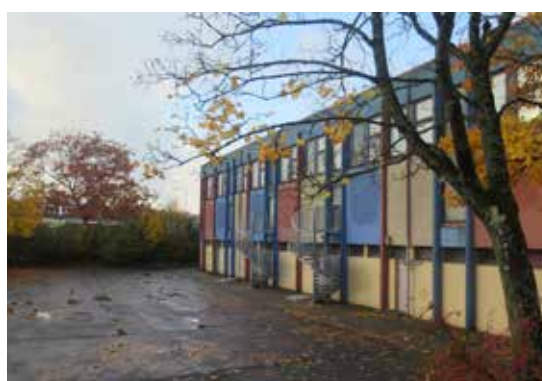
Gymnastikbyggnaden längst i öster.
