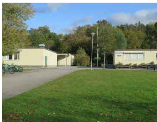
Skolanläggningen utgörs av låga byggnadslängor med en samlad gestaltning.
