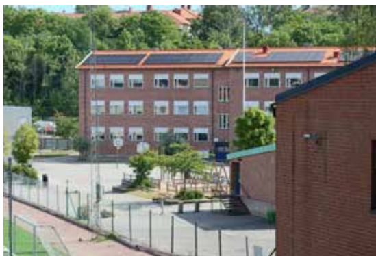
Den högre byggnaden ut mot gatan, ursprungligen för mellanstadiet, är uppbruten på tre svagt förskjutna volymer.
