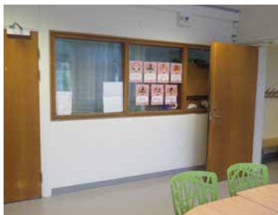
Från klassrumsbyggnadernas allmänna utrymmen finns partier med omålade träfönster in till klassrummen.
