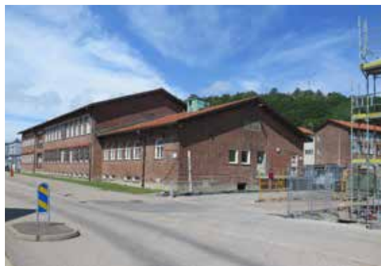
Skolans matsals- och köksdel ut mot Vinlandsgatan.
