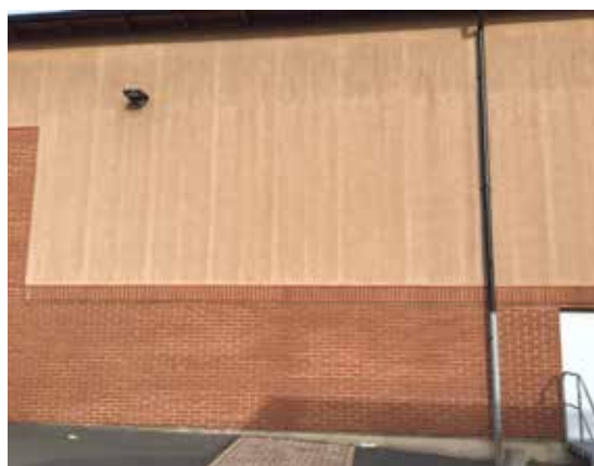
Fotografi av den nyare idrottshallen och den stora tomma väggen.
