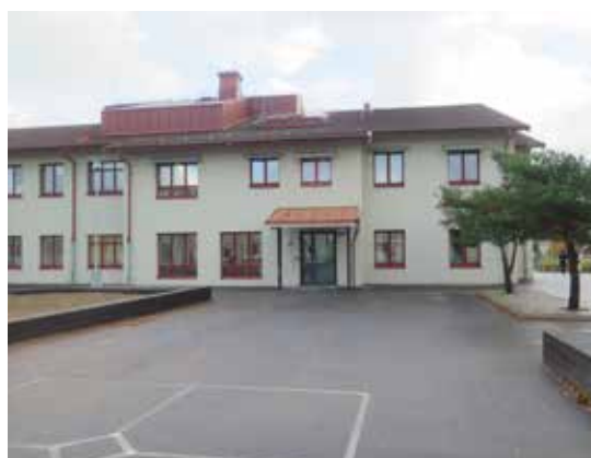
Del av 1990-talsdelens fasad mot skolgården i väster.
