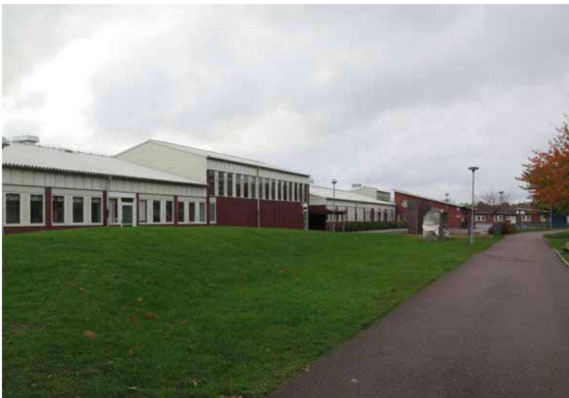
Eriksboskolan bestod ursprungligen av två enplanlängor placerade på rad, vilket skapade en långsträckt anläggning mellan bostadsbebyggelsen och Lärjeåns dalgång söder om skolan.
