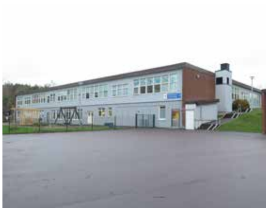
Den hästskoformade byggnadens utsida med varierande fönstersättning, sedd från gatan i väster.
