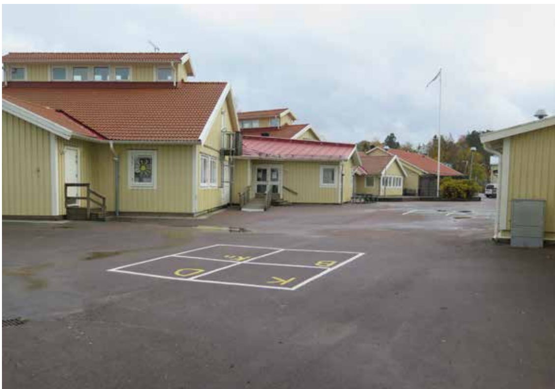
Klassrumsbyggnaden närmast bäckravinen i öster byggdes år 1990, och byggdes sedan till vid ett antal tillfällen under de följande tio åren. Till höger den paviljong som tillkom år 1996.
