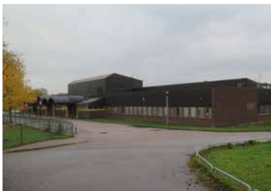
Klassrumsbyggnadens fasad mot norr.
