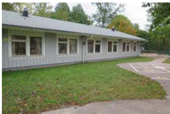
Fönstersättningens regelbundenhet skapar rytm åt fasaderna och är en arkitektonisk accent.
