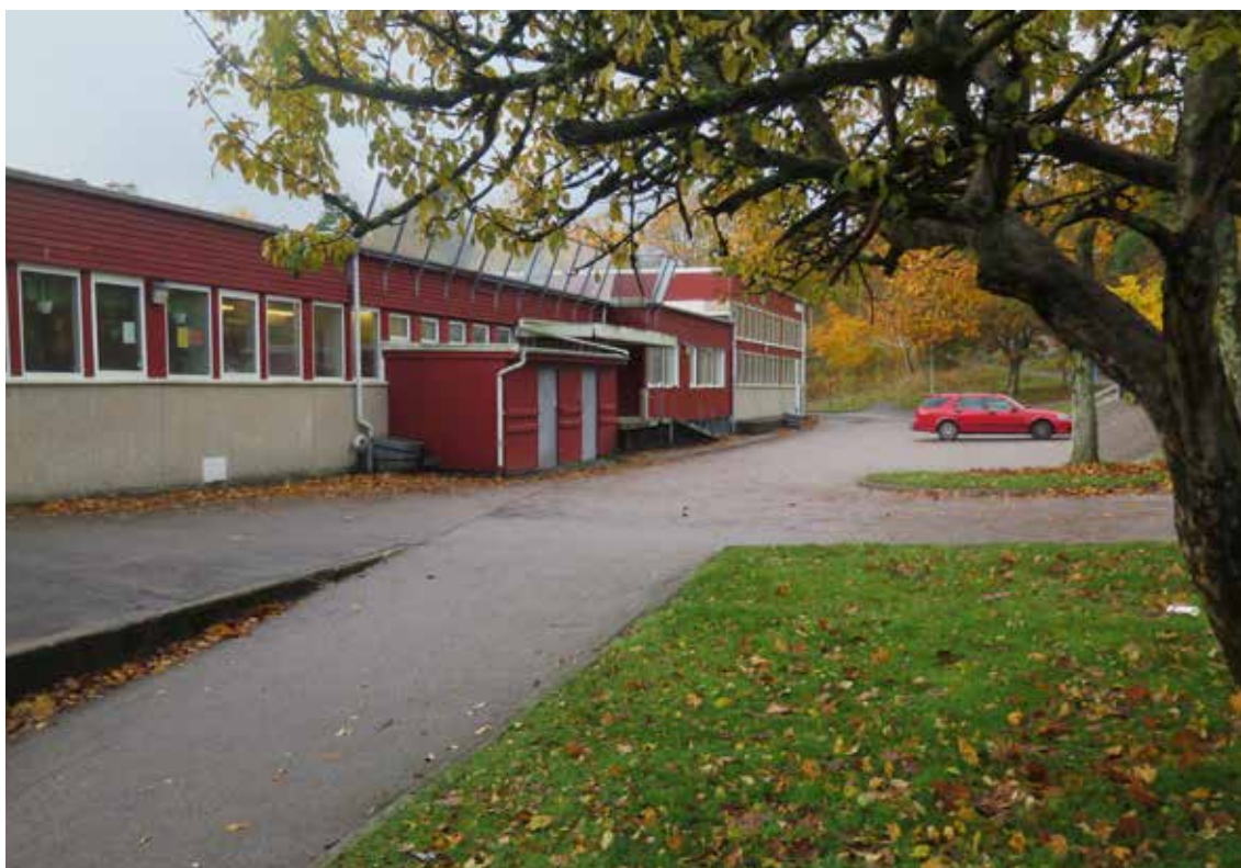
Byggnaden för gymnastik, matsal och slöjd utgör entré till skolområdet från Bredfjällsgatans flerbostadshus i norr. Gymnastikdelen är något högre än övriga delar av byggnaden.
