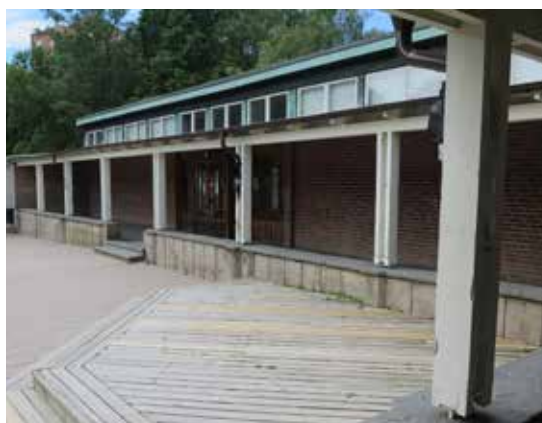
Klassrumslängorna mot öster och norr har alla kopparklädda överljuspartier.
