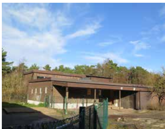
Den fristående gymnastikbyggnaden.
