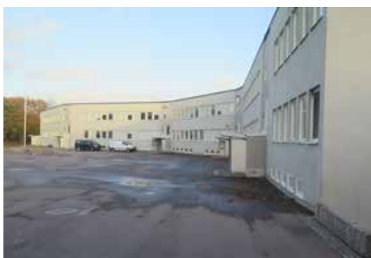
Den S-formade klassrumsbyggnadens norra fasad.
