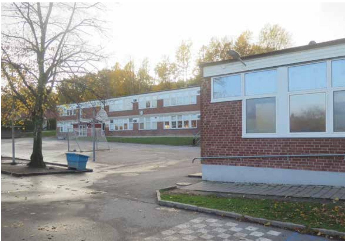
Tre av skolans byggnader är tydligt samgestaltade. Matsalsbyggnaden (närmast i bild) och mellanstadiebyggnaden delar bland annat material, fönstersättning och takform.
