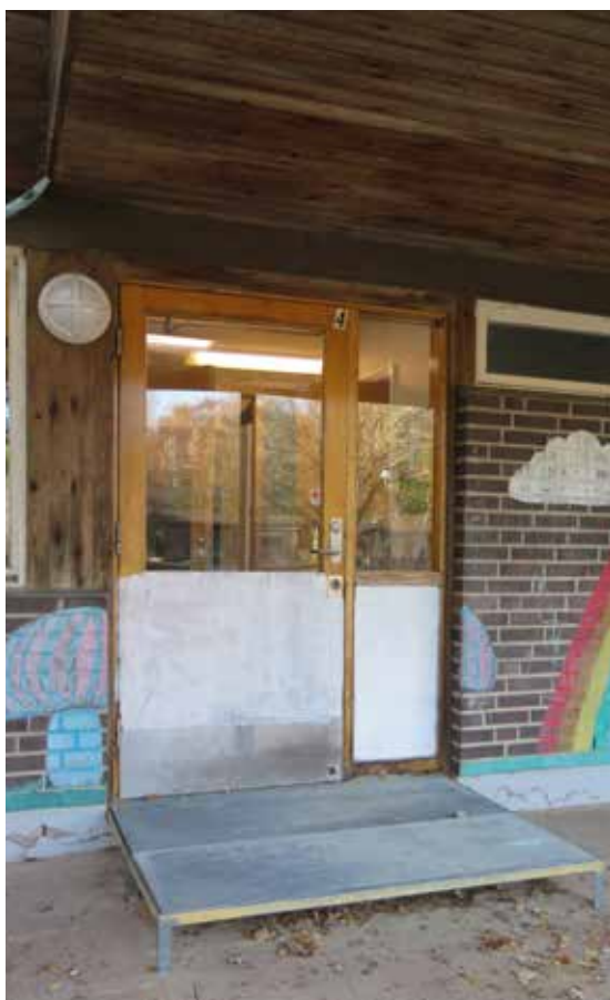
En av mellanstadiebyggnadens bevarade träportar.
