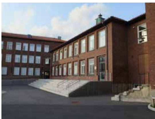
1950-talsbyggnadens mittparti mot skolgården. Fönsteromfattningarna är utförda som indrag i fasaden.
