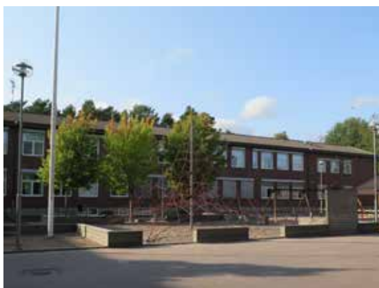
Den ursprungliga klassrumsbyggnadens fasad mot skolgården i öster.
