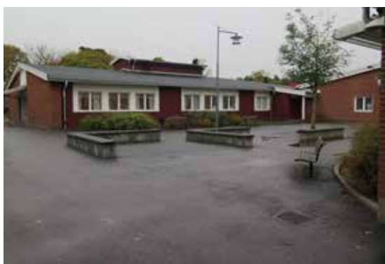
Ett av de gårdsrum som H-formen bildar.
