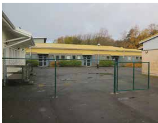
Gymnastikbyggnaden är den enda av skolans byggnader med bevarade ursprungliga dörrar.
