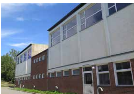
Den tvådelade gymnastikbyggnaden.
