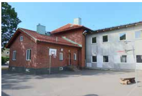
Den med småskolan sammanbyggda vaktmästarbostaden.
