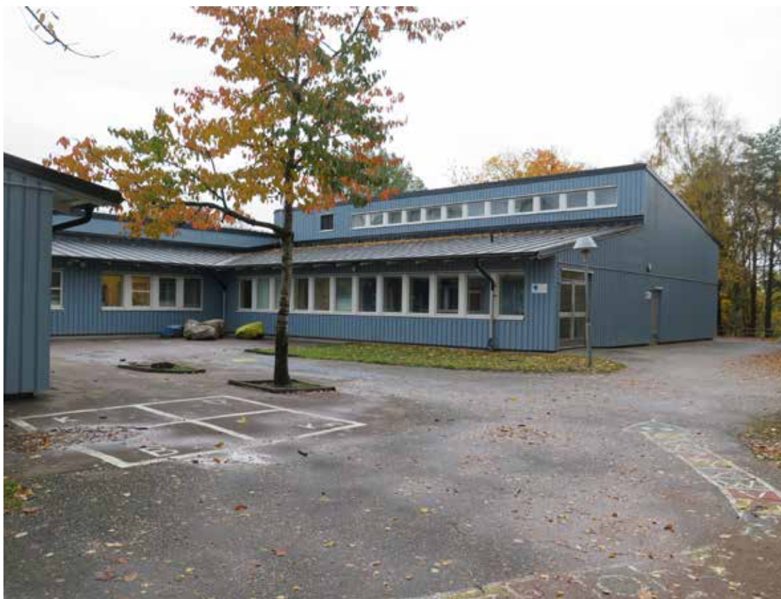
En av skolans utskjutande armar rymmer gymnastiksalen. Denna har ett tvådelat takfall vilket möjliggör en rad av smala fönster som ger överljus till gymnastiksalen.
