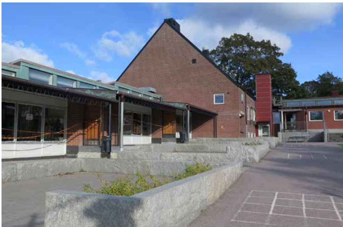
Delar av den ursprungliga små- och folkskolanläggningen sedd från skolgården. I mitten expeditjonsbyggnaden med brant skifferklätt sadeltak. På vardera sidan om denna finns lägre klassrumslängor som följer terrängen.
