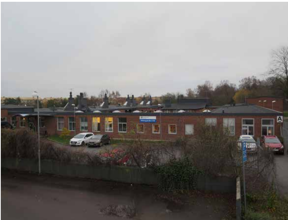
Skolanläggningen sedd från parkeringsdäcket i norr med huvudentrén till vänster i bild.
