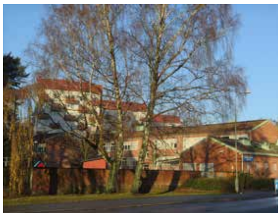
Mot gatan och Citytorget i öster avgränsas skolgården av en mur i samma röda tegel som byggnaderna.
