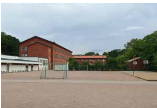
Skolan sedd från gården i sydväst. Till vänster gymnastikdelen.
