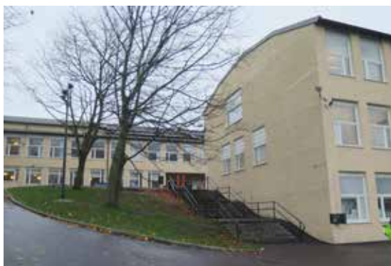
Delar av skolan sedd från öster, utmed spårvägen.
