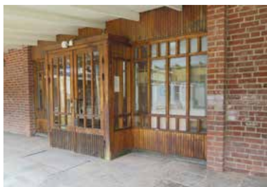
Ett av flera ursprungliga entrépartier till klassrum.
