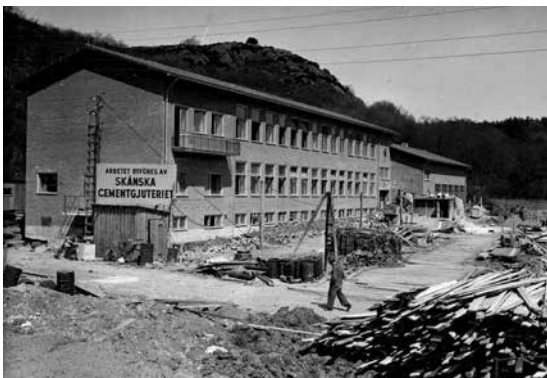
Toleredsskolans första byggnad under uppförande år 1941. Foto: Hjärnarkivet, Göteborgs stadsmuseum.
