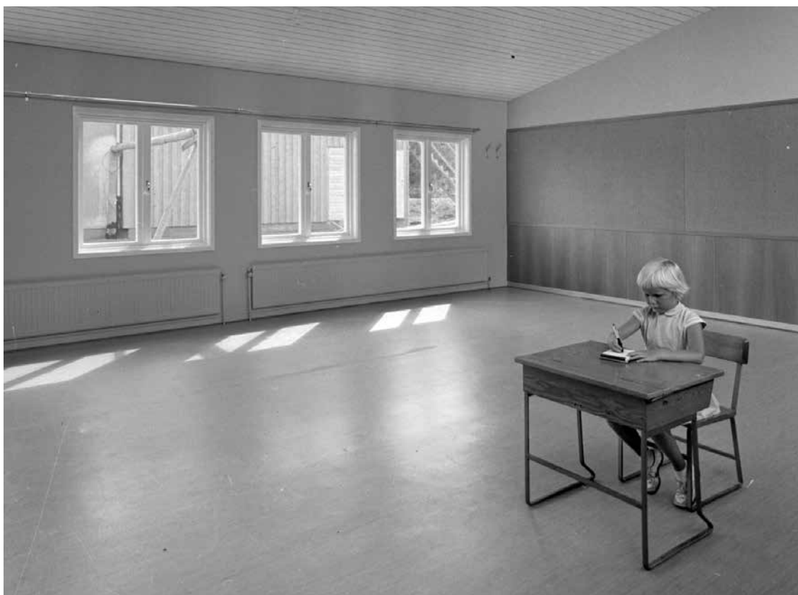
En ensam flicka testar klassrummen i den nya Järnbrottsskolan, strax innan invigning i augusti 1958. Foto: Hjärnearkivet, GSM
