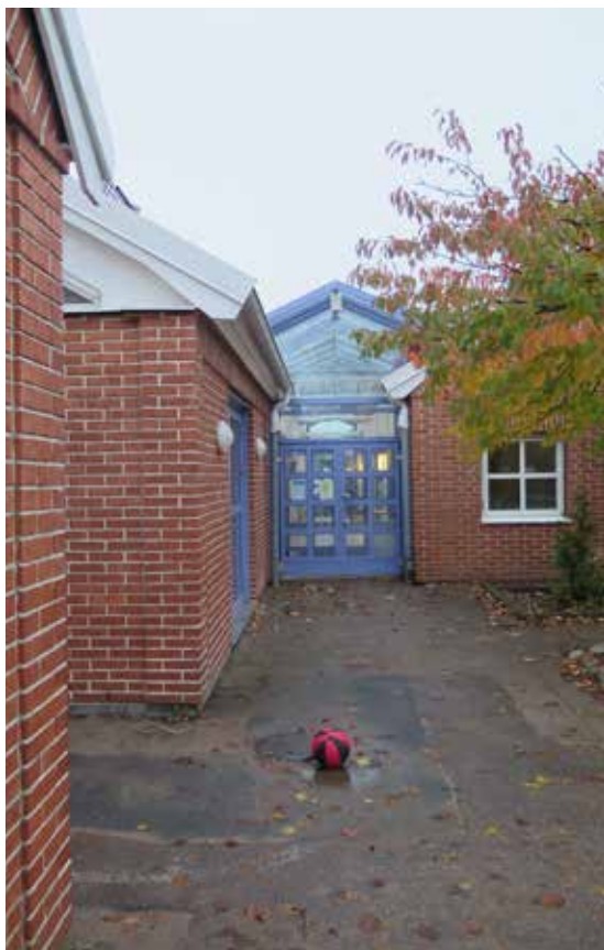
Anläggningens karaktärsstarka entréer med överljuspartier som löper mellan byggnadskropparna.
