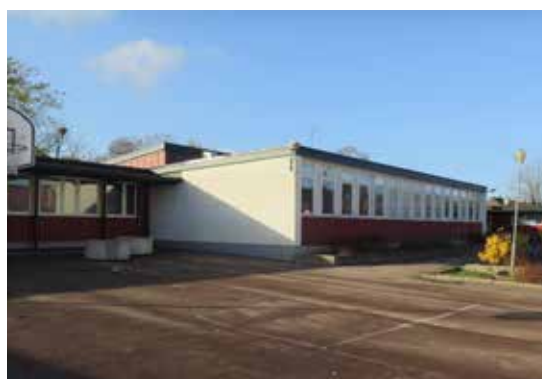
Den utskjutande, platsbyggda matsalen mot gården.
