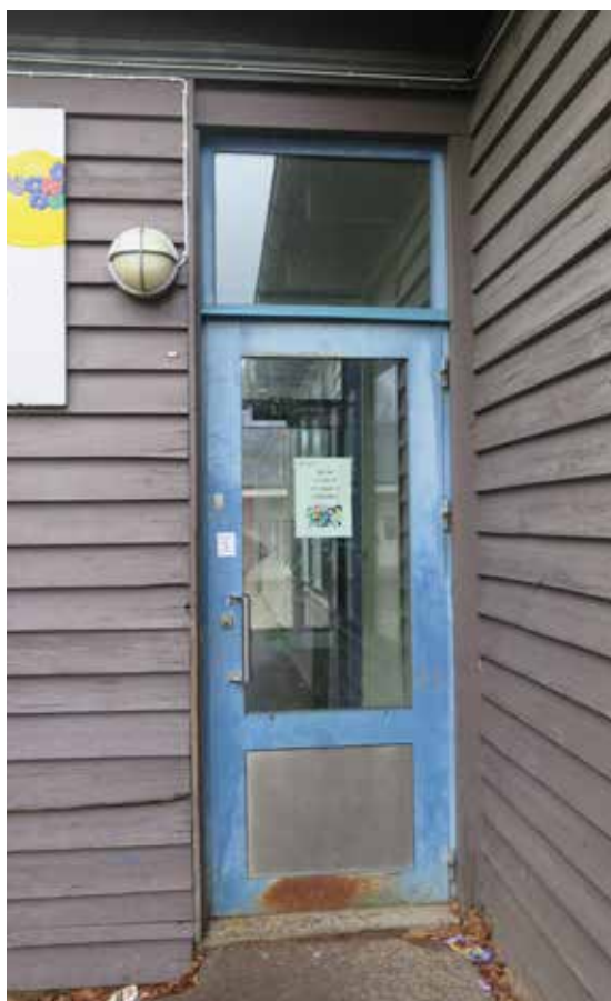
Ursprungligt glasat dörrparti med överljus.
