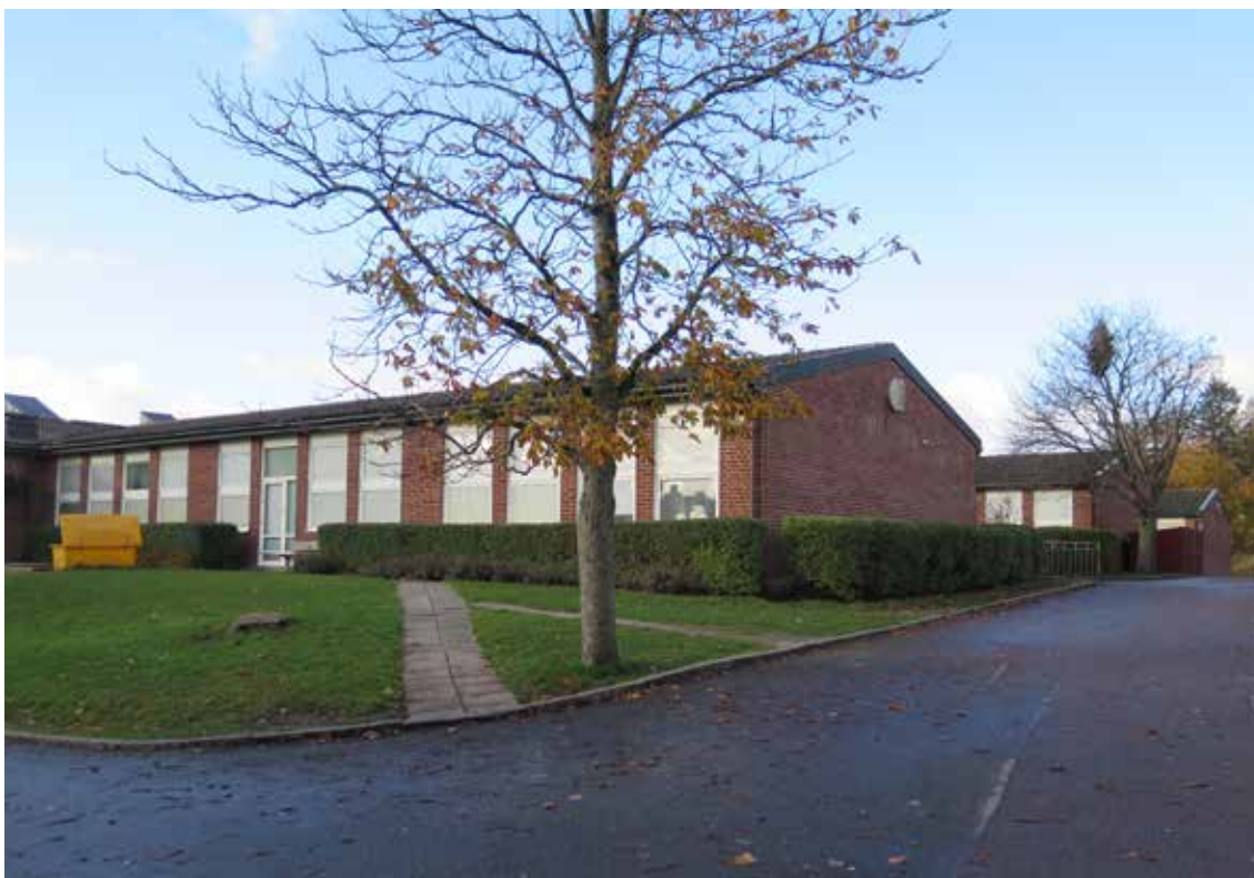
Den ursprungliga klassrumsbyggnaden utgörs av en tydlig kamstruktur, med utskjutande byggnadskroppar mot nordost. Sedan tidigt 2000-tal finns utskjutande byggnadskroppar även på den sydvästra delen av byggnaden.
