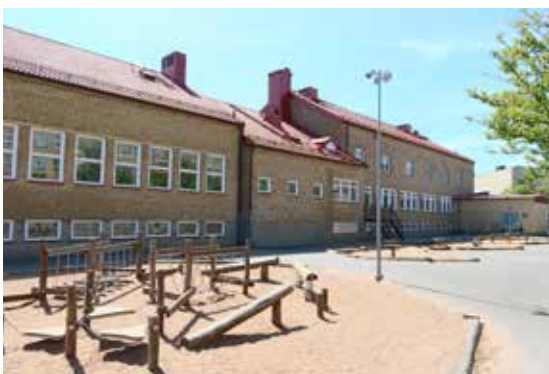
Den sammanbyggda södra raden av byggnadskroppar, innehållande matsal, samlingsal och storkök.
