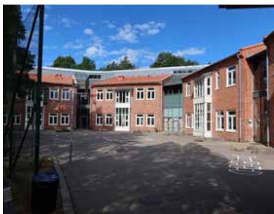
Den övre delen utgörs av en serie sammanbyggda mindre enheter med burspråk och korspostfönster.
