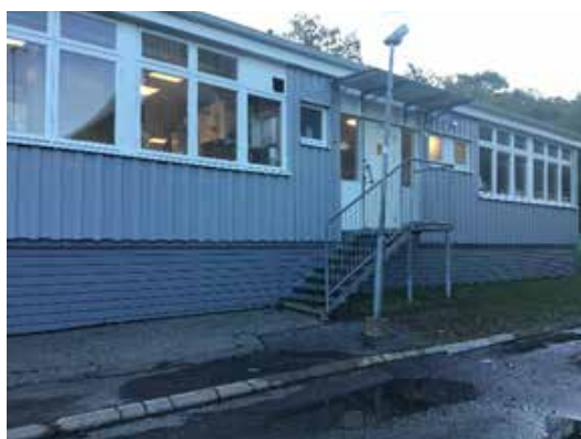
Den fristående träslöjdsbyggnaden.
