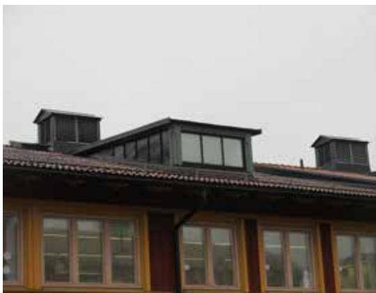
De låga takkuporna , klädda i bandtäckt plåt, präglar skolans tak tillsammans med det röda teglet.
