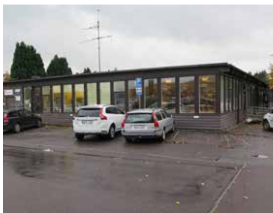
De till stora delar uppglasade fasaderna bidrar till en luftig karaktär.
