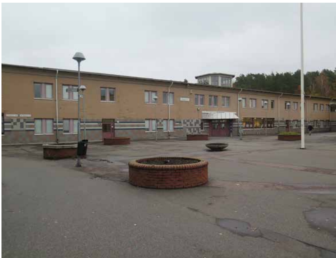
Skolans södra långsida vänder sig mot de övriga delarna av Lövgårdets centrumanläggning, med butiker, vårdcentral med mera. Samplaneringen med centrumet är ett tydligt karaktärsdrag för den övergripande planeringen av hela Lövgärdet.
