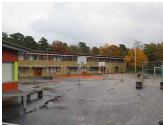
Den ursprungliga skolbyggnaden sedd från skolgården i söder. Till vänster skimtar den tillbyggda delen från år 2016.
