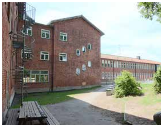
Klassrumsbyggnaden sett från mötet med det gröna bergspartiet i norr. Här är fönstersättningen tydligt särskiljande.
