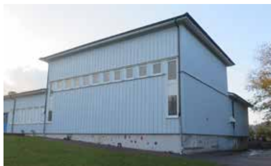
Gymnastikdelen reser sig över övriga anläggningen.
