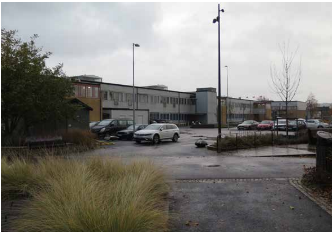
Skolans enda stora, långsträckt byggnad sedd från sydväst, i anslutning till mötet med centrumanläggningen Selma Lagerlöfs Torg. På fasaden syns de oregelbundet placerade franska balkongerna i det övre planet.
