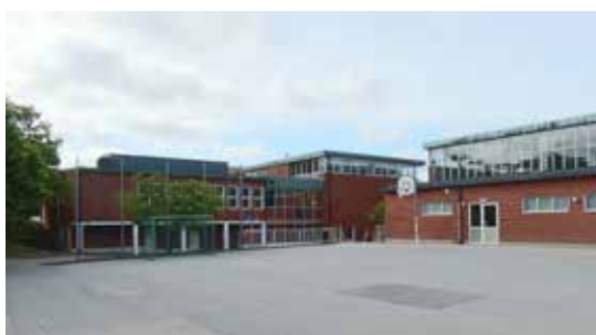
Matsals- samt gymnastikbyggnaden sedda från skolgården.
