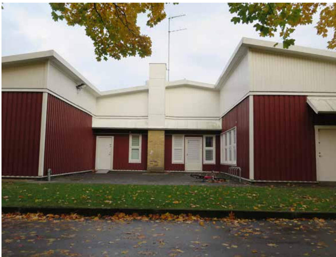
Skolans H-form skapar mot väster och öster små gårdsrum mellan byggnadskropparna. Här finns utanpåliggande murstockar med en nedre del i gult tegel. Dessa är ett särskiljande signum för Rannebergen södra.
