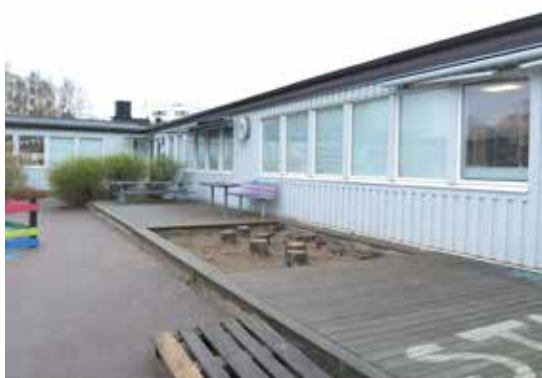
Byggnadernas fasader mot det skyddade gårdsrummet.
