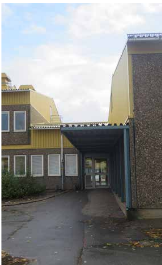
Mötet mellan högstadie- och matsalsbyggnaden.
