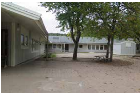
Gunnaredsskolan består av en T-formad enplansbyggnad och en parallell länga. Sedan 1992 är dessa sammanbyggda.
