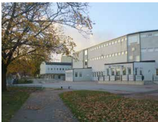
Klassrumsbyggnaden och specialsalsbyggnaden sedda från gården i söder.
