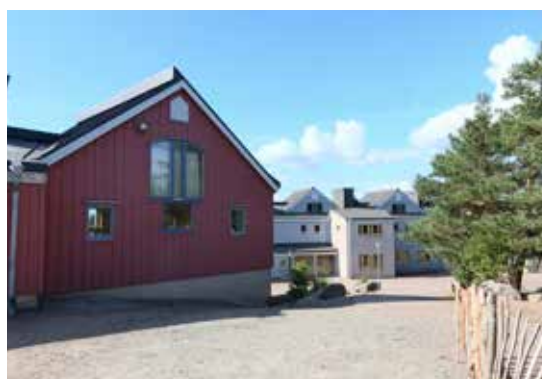
Skolans bägge byggnader är tydligt samgestaltade.
