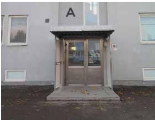
Klassrumsbyggnadens entrépartier mot gården i norr med vindfång i ursprungligt utförande.
