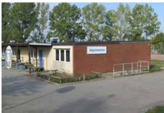
Klassrumslängornas fasadindelning med tegel på gavlarna och panel på långsidorna.
