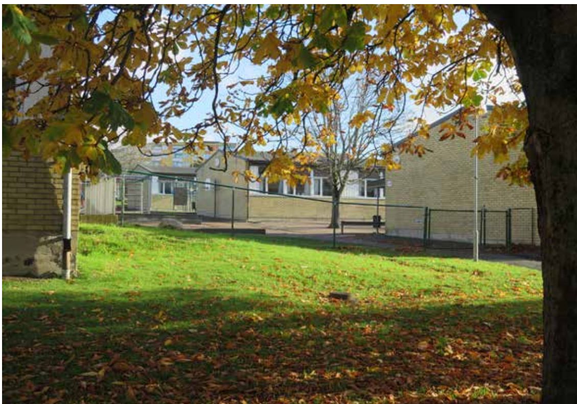
Vättnedalsskolan präglas tydligt av den totala funktionsuppdelning som finns mellan olika byggnader. Ut mot spårvägen i söder ligger de tre lågstadiebyggnaderna med separata klassrumsentréer på rad.
