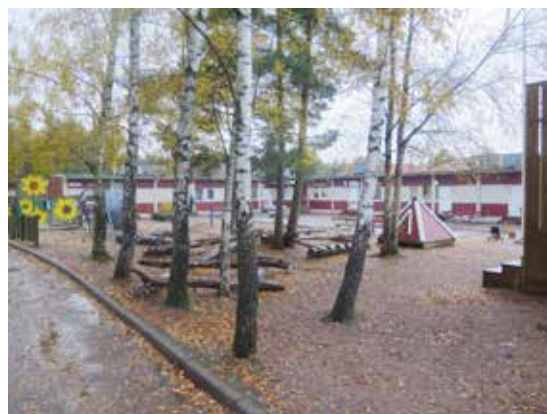
Skolans byggnader utgörs av sammanfogade moduler.
