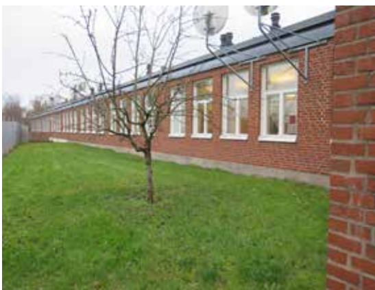
En av skolans låga längor med fasader i rött tegel.
