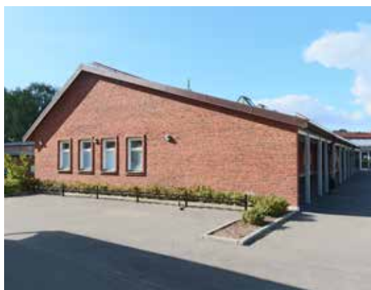
Matsalsbyggnaden med sitt assymetriska takfall och utskjutande fönsteromfattningar på gaveln.
