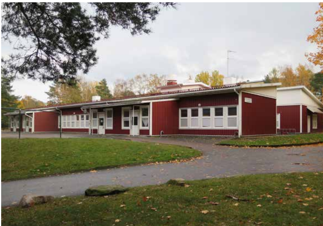
Den småskaliga ursprungliga "lek lågstadieskolan" är en tydlig kontrast till de höga flerfamiljshus som omger skolan. Över fasaderna finns ett flertal band med tvådelade vita fönster.
