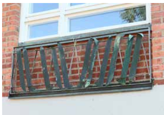
Trapphusfönstrenas bröstdningsutsmyckningar i koppar.
