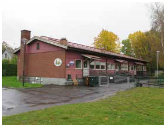
Den mer förändrade gårdsfasaden mot väster.
