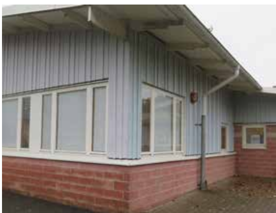
Fasadpanelens ribbor är mönsterskapande placerade.
