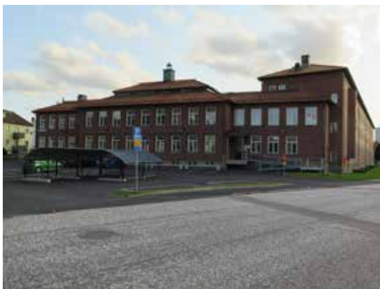
1950-talsbyggnadens fasad mot norr med det markerade mittpartiet och säteritak.
