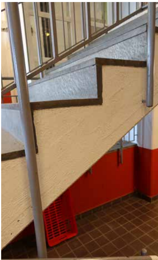
En av klassrumsbyggnadens trappor klädda i skifferplattor
