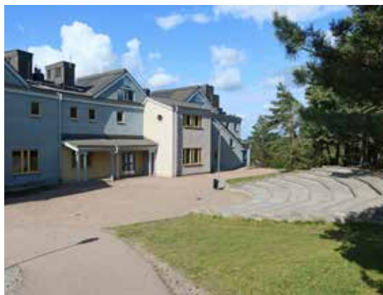
Den duvblått putsade huvudbyggnadens fasad mot gården med sin amfiteater.
