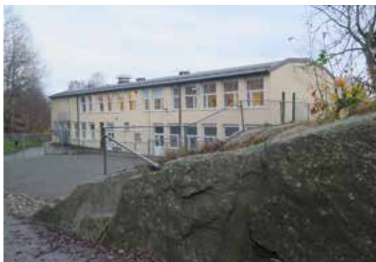
Den västra klassrumsbyggnaden med bågformat tak.
