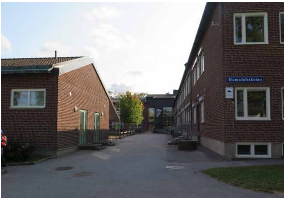
Entrén in till Ramsdalsskolans östra gård mellan matsals- och gymnastikbyggnaden (till vänster) och klassrumsbyggnaden. Rakt fram i bilden syns den sentida utbyggnaden.
