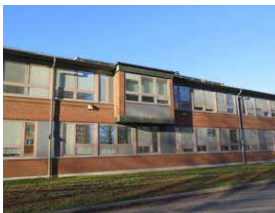
Huvudbyggnaden från 1960-talet med sitt burspråk mot öster.
