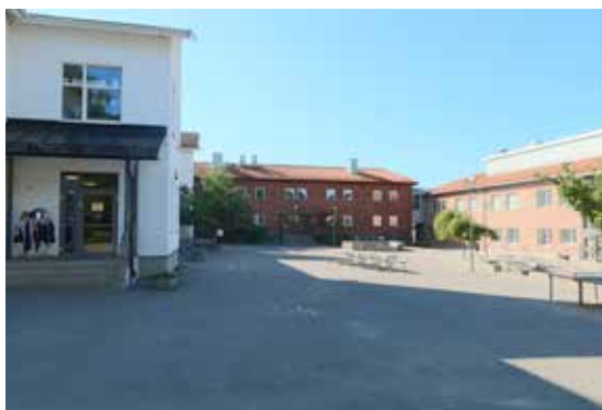
Småskolebyggnaden från år 1952 flankeras idag på bägge sidor av byggnader från 2000-talet.
