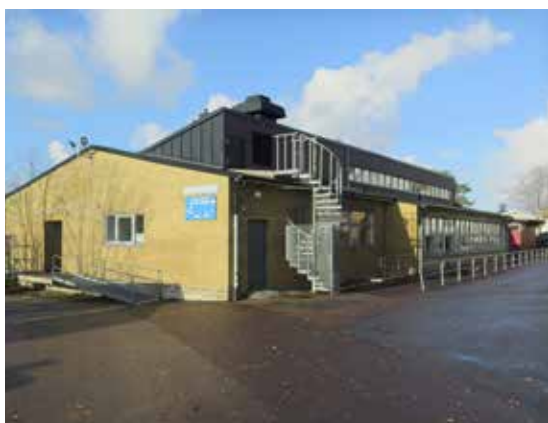
Matsalsbyggnaden med sin särskiljande takform som ger överljus till matsalen.
