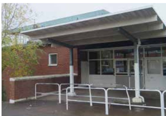
Matsalsbyggnadens entréparti mot öster.
