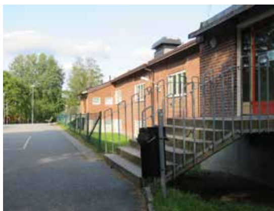
Den ursprungliga klassrumsbyggnadens lägre fasad mot gården i väster med sina breda entrétrappor.
