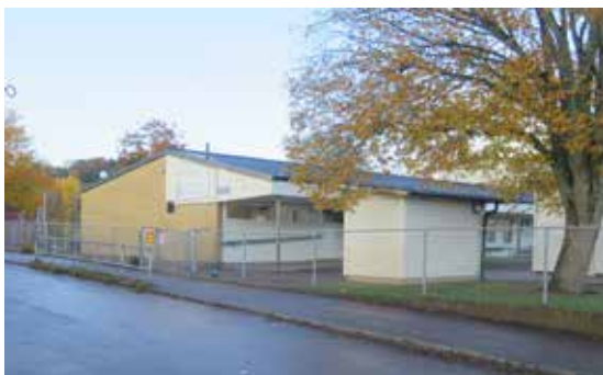
Den västra klassrumslängan från 1960-talet med förändrat tak (de vita partierna är senare tillkomna).
