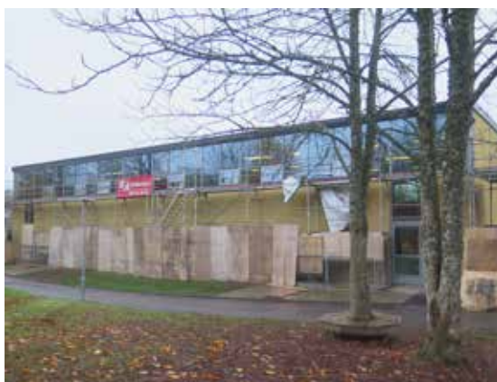
Gymnastikbyggnaden med stora glaspartier överst och som vertikala rader vid långsidans ytterkanter.
