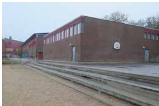
De ursprungliga delarna av Lindåsskolan sedda från öster med gymnastikbyggnaden närmast i bild.
