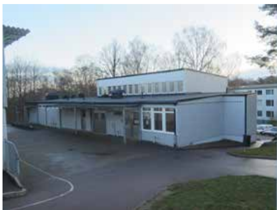
Den fristående byggnaden för matsal, kök och gymnastik intill entrén till skolan.
