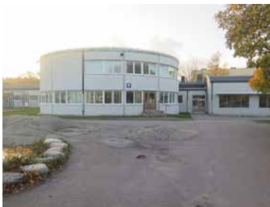
Den runda matsalsdelen. Till höger den utbyggda delen av specialsalsbyggnaden.
