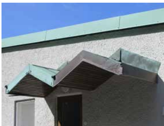
Mossebergsskolan är på detaljnivå välbevarad. På bild ett tidstypiskt skärmtak till köksdelen.
