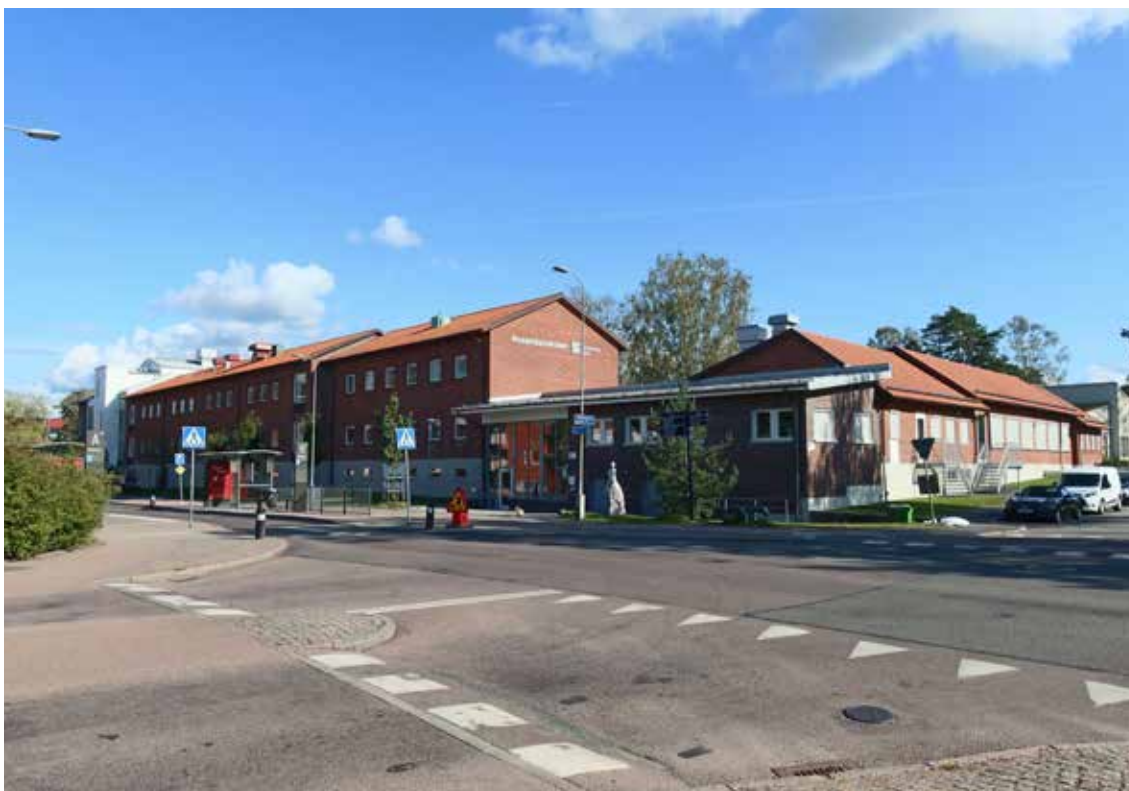
Ut mot omgivande gator är den ursprungliga skolanläggningen även efter om- och tillbyggnaderna väl avläsbara och viktiga delar av helhetsmiljön runt Stabbetorget. Till vänster den ursprungliga klassrumsbyggnaden och till höger matsalen.
