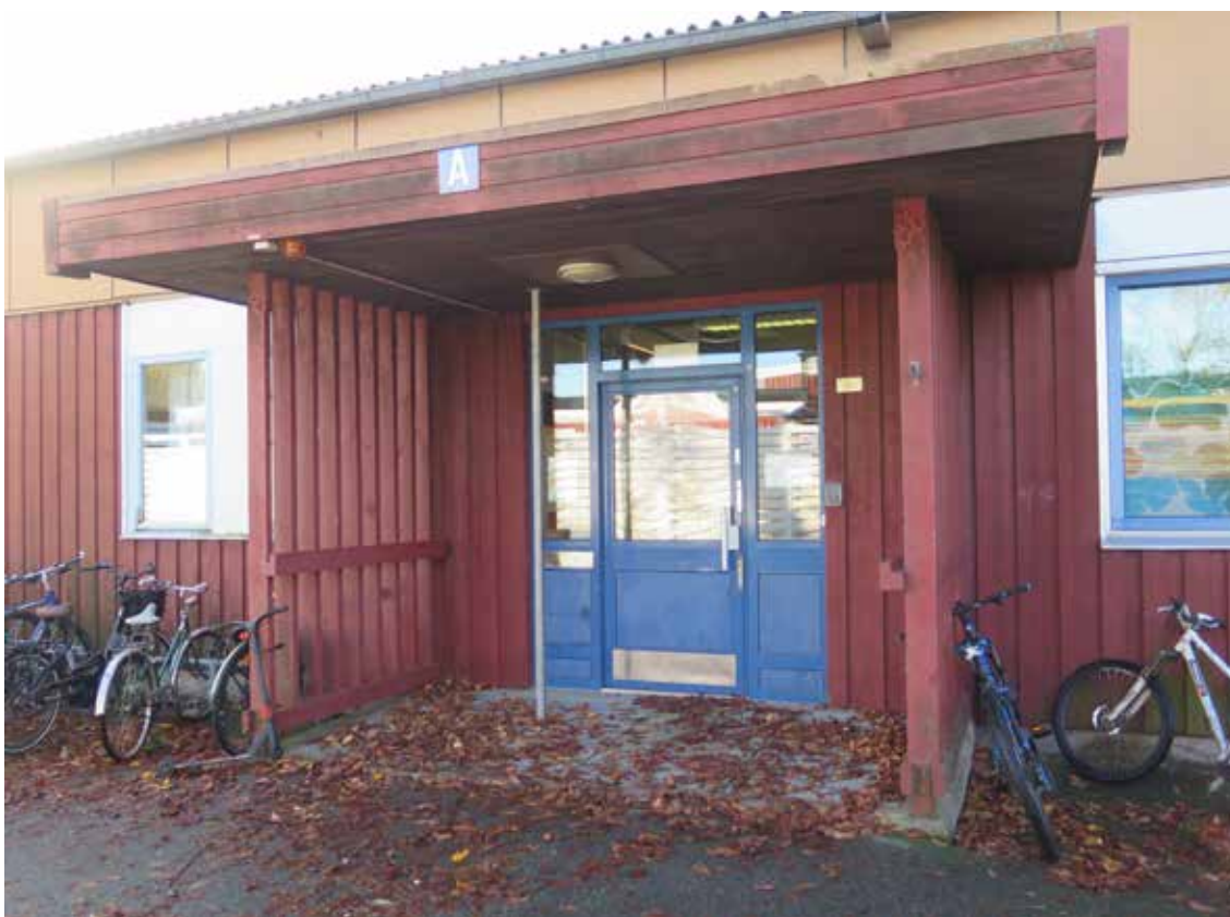
Ett av den ursprungliga skolbyggnadens bevarade entrépartier med skärmtak "uppburet" av spaljéer i rödmålat trä. Entréporten är utbytt mot en standardiserad aluminiumdörr med sido- och överljus.
