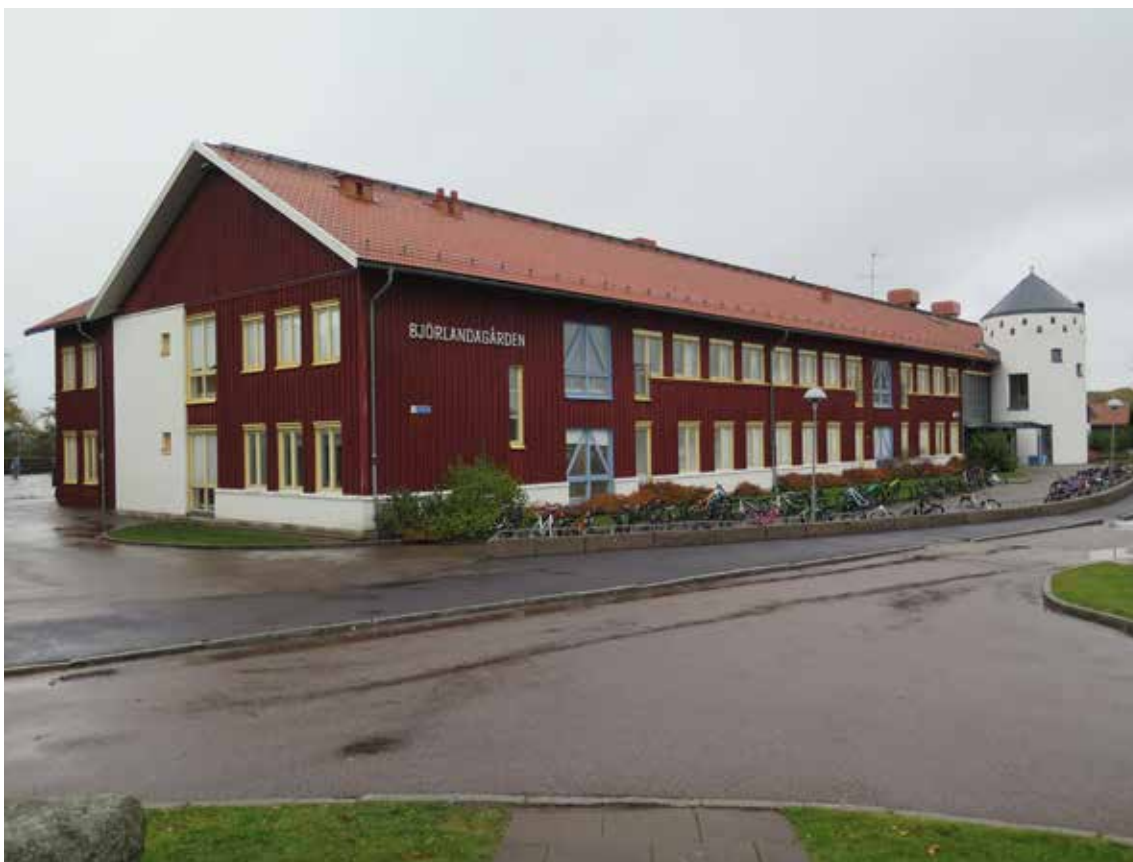
Skolans huvudfasad mot Kongahällavägen med sina blå fönsterpartier som påminner om ladugårdsportar och sitt utanpåliggande trapphus i form av ett vitputsat torn.
