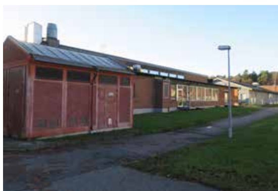
Matsalsbyggnaden sedd från nordost.
