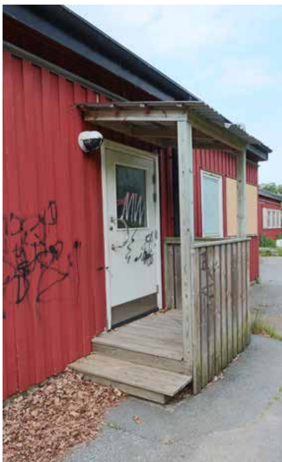
En av de enkla entréerna till den äldre, östra paviljongen.
