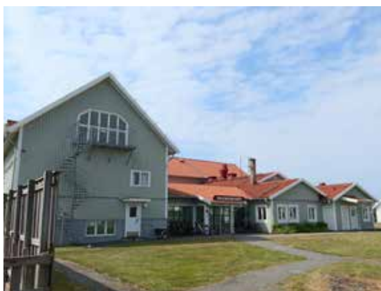
Det senare tillbyggda Allaktivitetshuset (till höger) är sammanbyggt med den äldre folkskolan.
