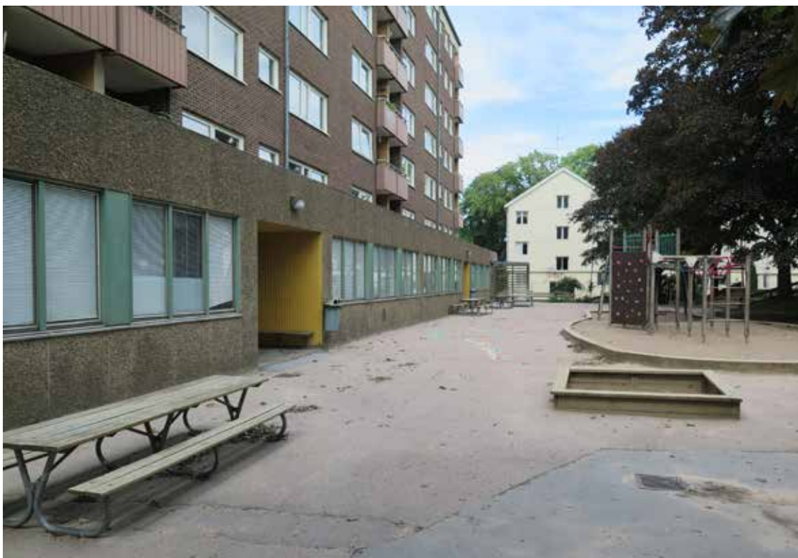
Landalaskolan är det enda bevarade exemplet på en skola placerad i bottenvåningen på ett flerfamiljshus, en typ av skola som under 1950-70-tal var relativt vanlig i Göteborg. Skolvåningarna särskiljs från bostadsvåningarna genom olika fasadmateriell.
