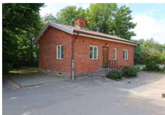
Den fristående före detta vaktmästarbostaden.
