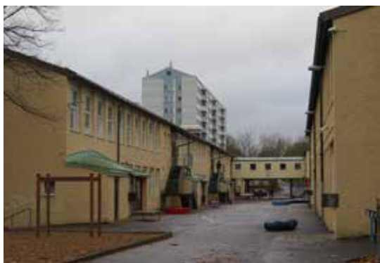
”Skolgatan” med sin förbindelsegång i det övre planet.
