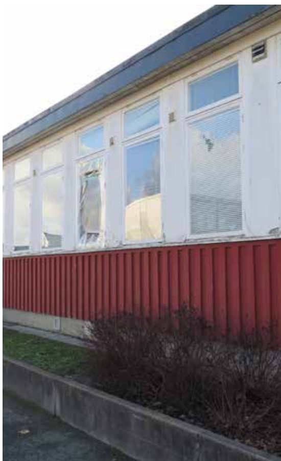
Klassrumsbyggnadens rader av vitmålade träfönster.
