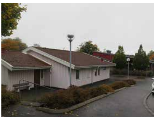
En av anläggningens äldsta byggnader, från år 1984.
