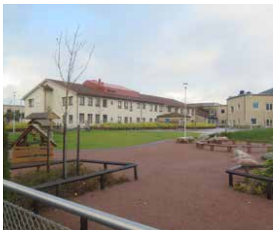
Den bevarade byggnadskroppen som år 1999 lades till den ursprungliga skolan från år 1953 sedd från sydöst.
