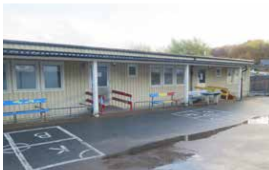
Den östra av 1960-talslängorna med skärmtak mot gården.
