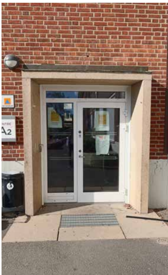
Utbytt port med ursprunglig omfattning i granit.
