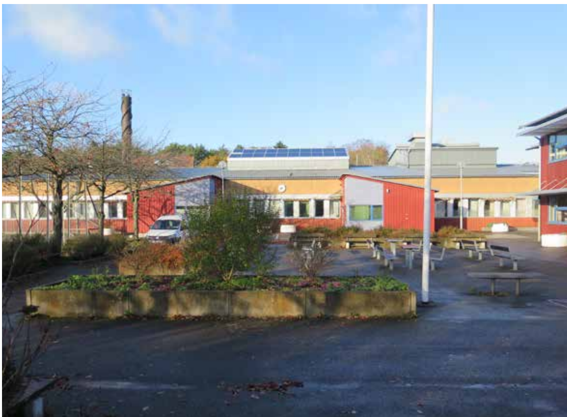
Den ursprungliga långsträckt skolbyggnaden i en våning med påbyggda byggnadskroppar och en markant lanternin över den tidigare öppna ljusgården. I bakgrunden ansas den karaktärsskapande höga skorstenen.
