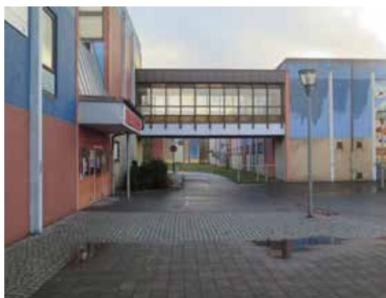
Förbindelsegången mellan klassrumsbyggnaden och byggnaden för matsal och slöjd är ett särpräglat inslag i skolmiljön.
