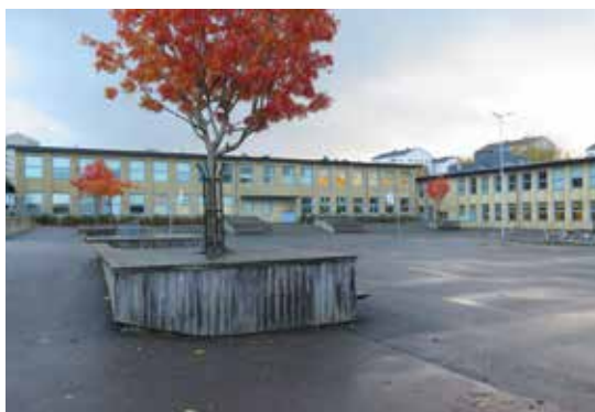
Mellan- och högstadiets klassrumsbyggnader sedda från den centrala skolgården.
