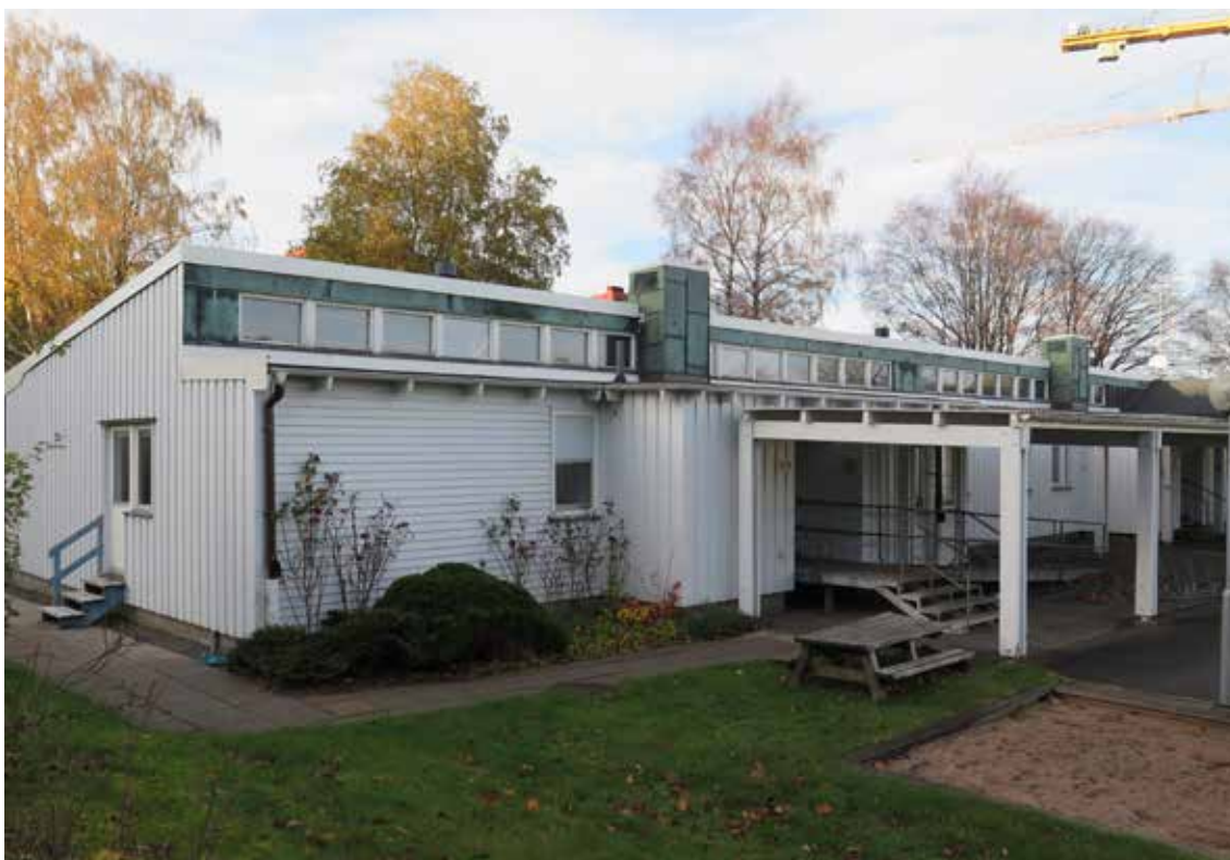
Den före detta lågstadianläggningen är tidstypisk och mycket välbevarad i utformning och material, till exempel takfot och överljuspartier klädda i kopparplåt.
