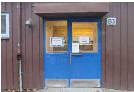
En av lågstadiebyggnadernas ursprungliga portar.
