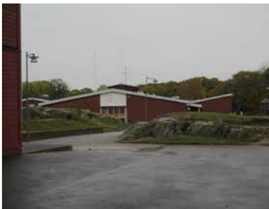
Gavlarnas vitmålade panelpartier markerar platsen för skolans ursprungliga glasade korridorer.
