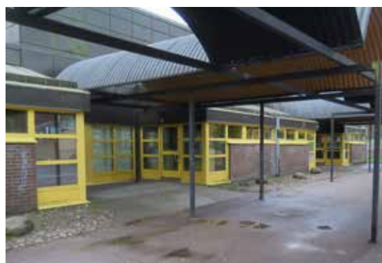
Ett av klassrumsbyggnadens entrépartier mot norr.
