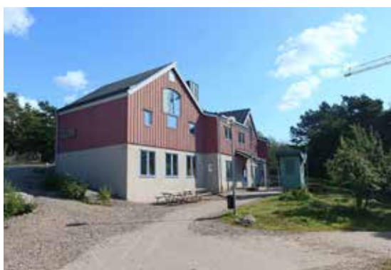
Skolans mindre byggnad har fasader i rosa locklistpanel.
