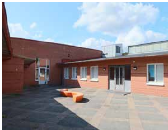
Mot öster gör skolans indelning i "hembyar" att små gårdsrum med olika mönsterlagd markbeläggning skapas.
