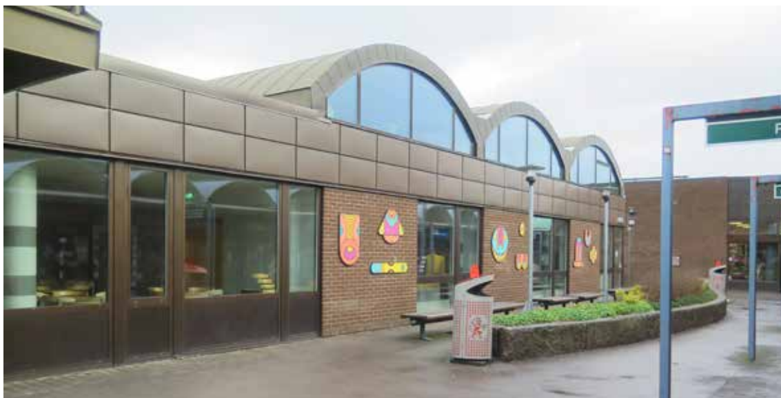
Skolanläggningens fasad mot centrumets gågata, med friare takformer och fönstersättning.
