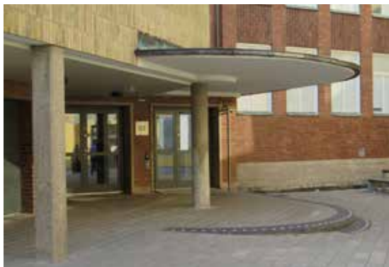
Det rundade betongskärmtaket över en entré från passagen in till skolgården.
