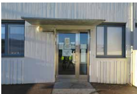
Byggnadens fasader i träimiterande betong.
