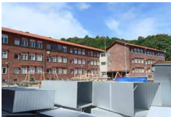
Klassrumsbyggnadens två sammanfogade delar sett från gården i öster. Entrépartiets fasad är klädd i ljust kakel.
