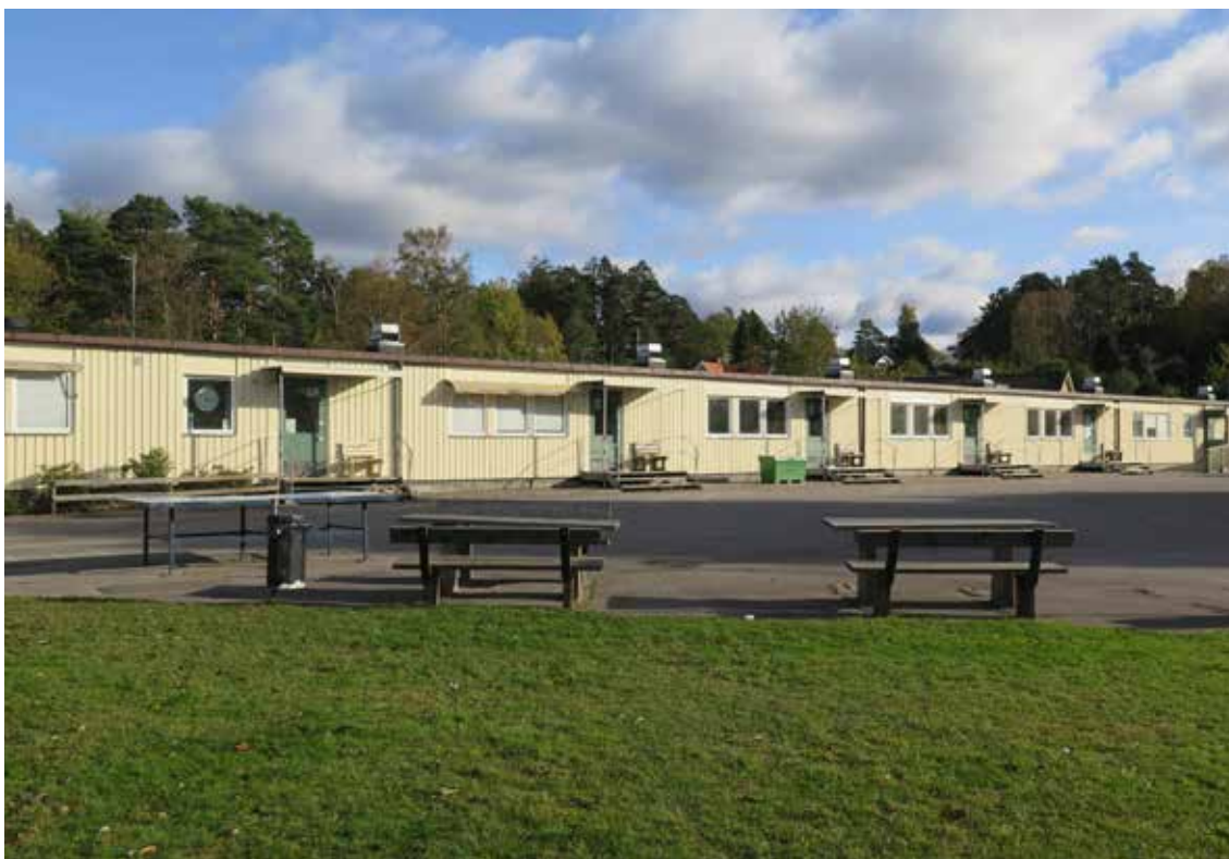
Den U-formade klassrumsbyggnaden utgör en långsträckt enhet bestående av sammanfogade paviljonger. De flacka pulpettaken bidrar till den ursprungliga, småskaliga prägeln.
