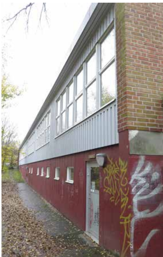
Den östra längans souterrängvåning med fasader i rödmålad betong.
