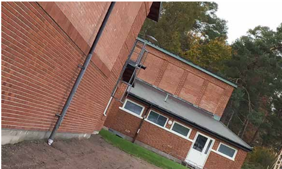
Den äldre idrottshallen, snett bakom den nyare.
