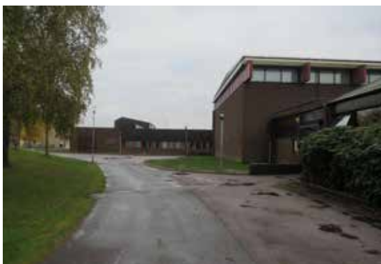
Sporthallen med sina markanta, frilagda bjälkar.
