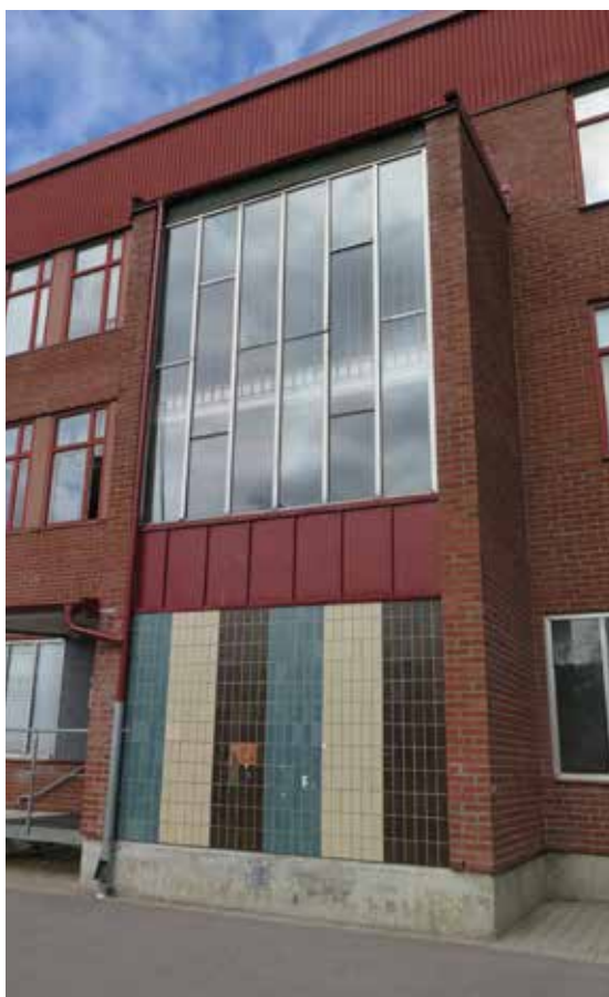
Ett av de utanpåliggande trapphusen med mosaik.
