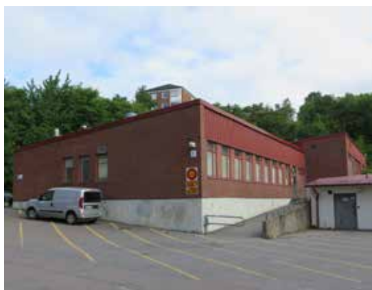
Den fristående matsals- och slöjdbyggnaden väster om klassrumsbyggnaden.
