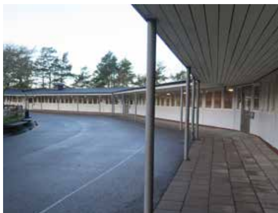
Runt hela den runda klassrumsbyggnadens inre gårdsfasad löper ett skyddande skärmtak.
