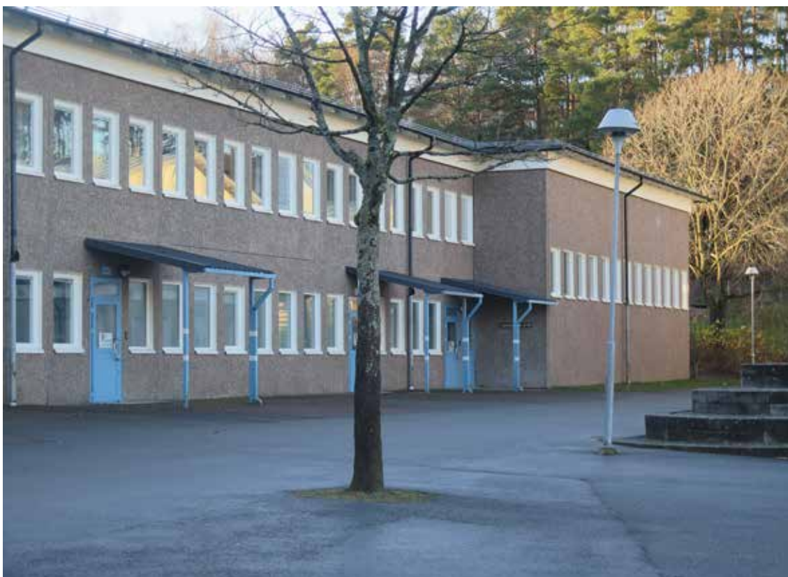
Skolans fasader av skivor med frilagd ballast är ett viktigt uttryck som också binder samman skolan med de intilliggande flerfamiljshusen. Gymnastiksalen till höger har en särskiljande fönstersättning.
