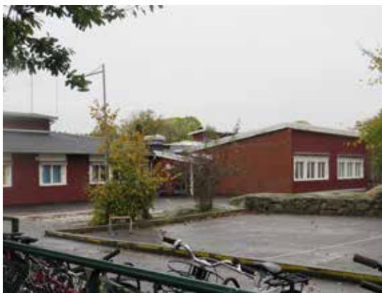
Den södra byggnadskroppen med ursprungligt pulpettak.
