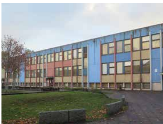
Klassrumsbyggnaden i norr med fält målade i blått, rosa och gult som skolan målades i år 2004.
