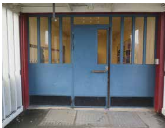
Ett ursprungligt bevarat entréparti med sido- och överljusparti. Liknande partier finns även målade i svart.
