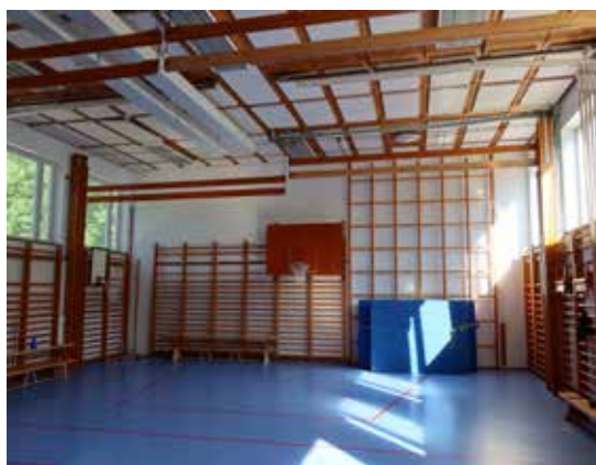
Gymnastiksalen har en nästan orörd karaktär, med bevarade tak- och väggbeklädnader samt väggfasta redskap.
