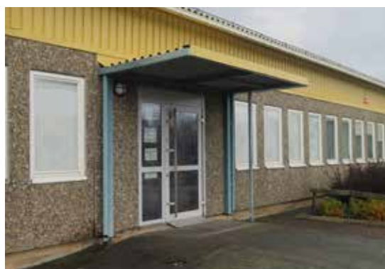
Skärmtak över låg- och mellanstadiebyggnadens entréer.
