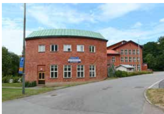
Aulan samt gavelparti med stora korspostfönster till vänster.
