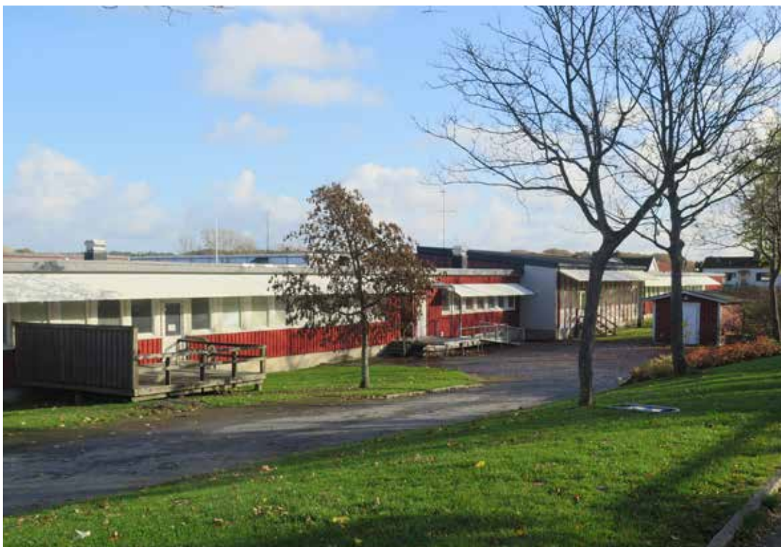
Nya Åkeredsskolan utgörs av sammanbyggda, låga längor ordnade i en hästskoform. Centralt i hästskon finns den platsbyggda matsalsdelen som tydligt framträder i fasaden.
