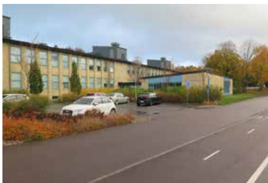
Mellan- och högstadiets östra klassrumsbyggnad och den utanpåliggande delen för samlingshall och musik.
