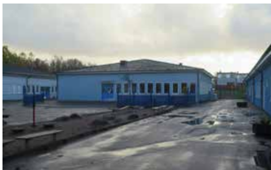
Den ursprungliga matsalsbyggnaden med den samtida klassrumslängan till vänster.
