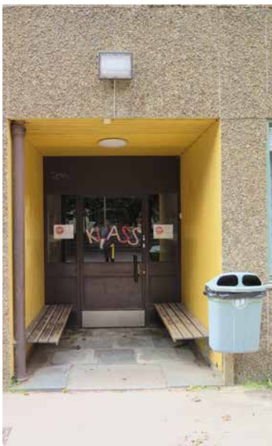
En av de i fasaden indragna entréerna med gulmålad panel.
