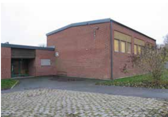
Gymnastiksalen med delvis igensatta fönsterpartier.
