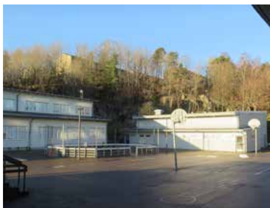
Gymnastikbyggnaden från 1990-talet till höger och byggnad från år 2012 till vänster.
