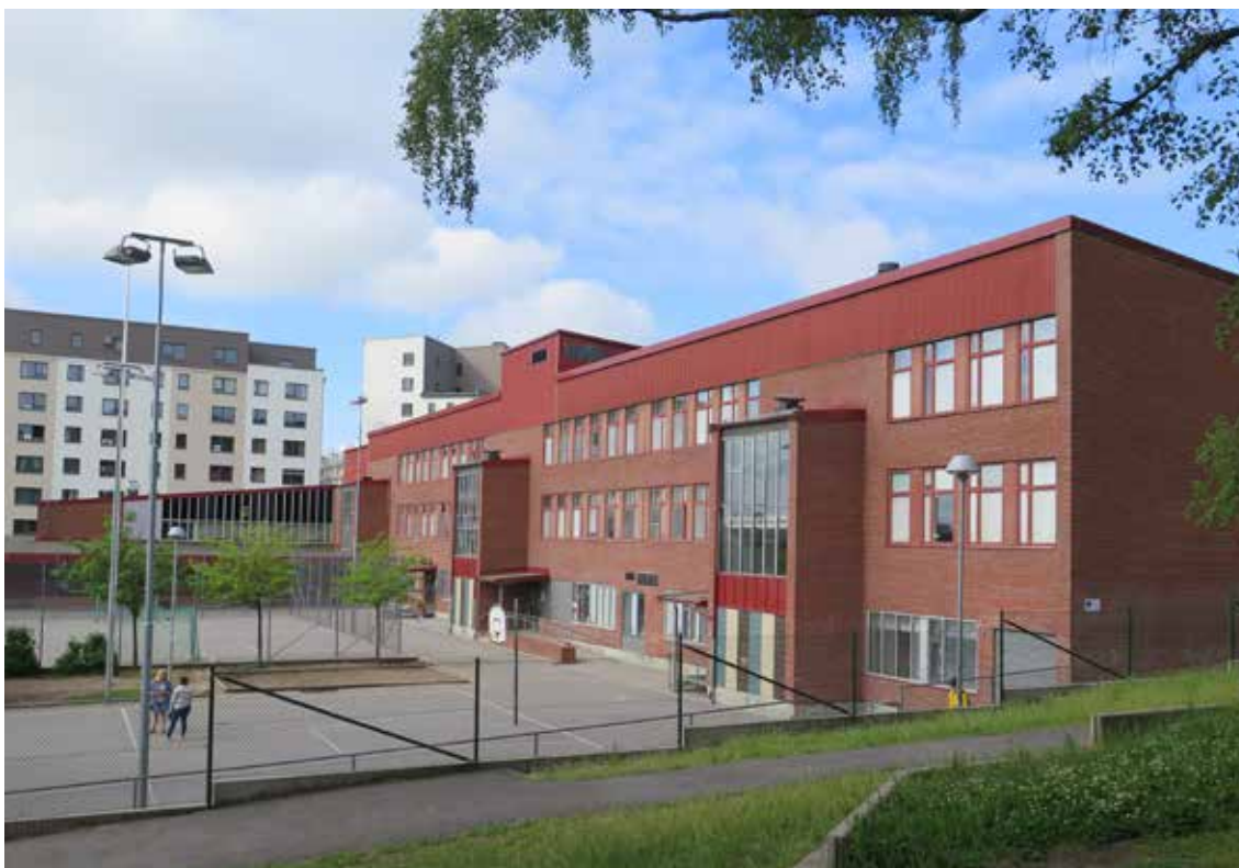
Flatåsskolans bevarade U-formade klassrumsbyggnad skapar en skyddad gård där fasaderna, fönstersättningen och trapphusen har en tydligt värdebärande karaktär.
