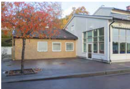
Den tillbyggda matsalen till höger.
