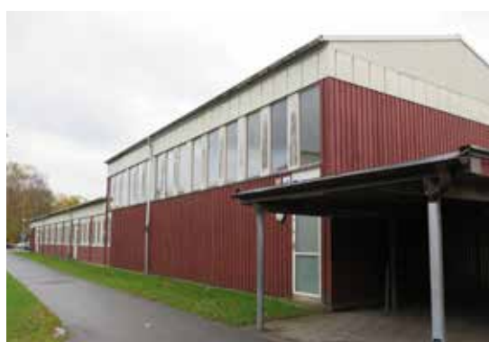
Byggnaden för gymnastik, matsal och slöjd.
