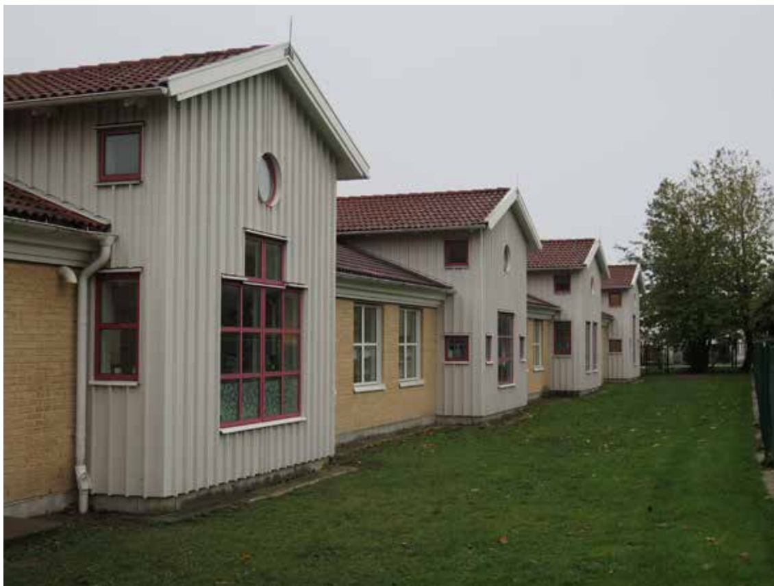
Skolans fasad mot Hjviks bryggväg med sina utskjutande gavelpartier med särskiljande fönstersättning.
