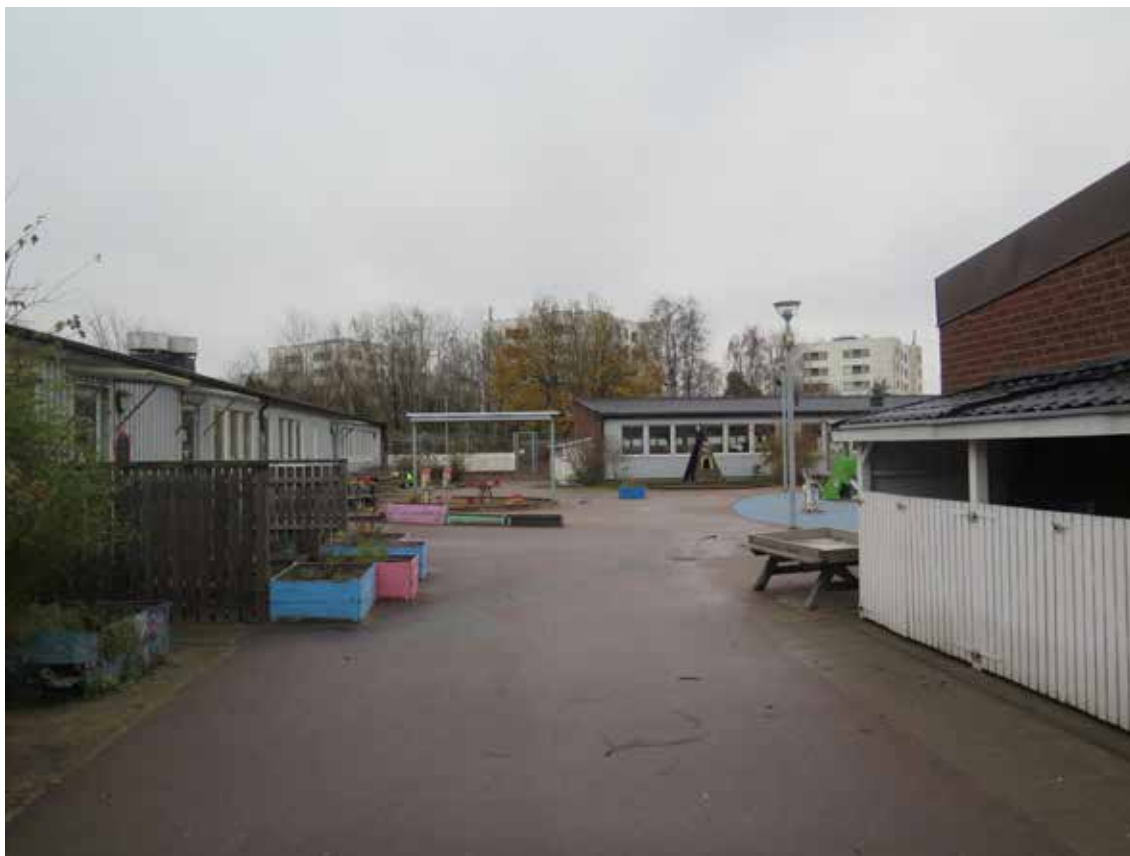
Skolans två byggnader omgärdar en skyddad gård på en höjdplatå.
